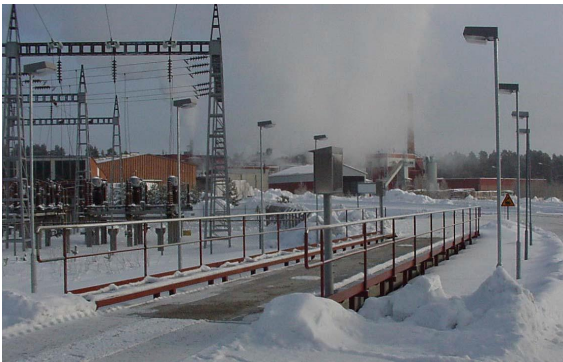
Рисунок 2 – Общий вид весов Scalex 1001 (ГПУ из железобетона)
