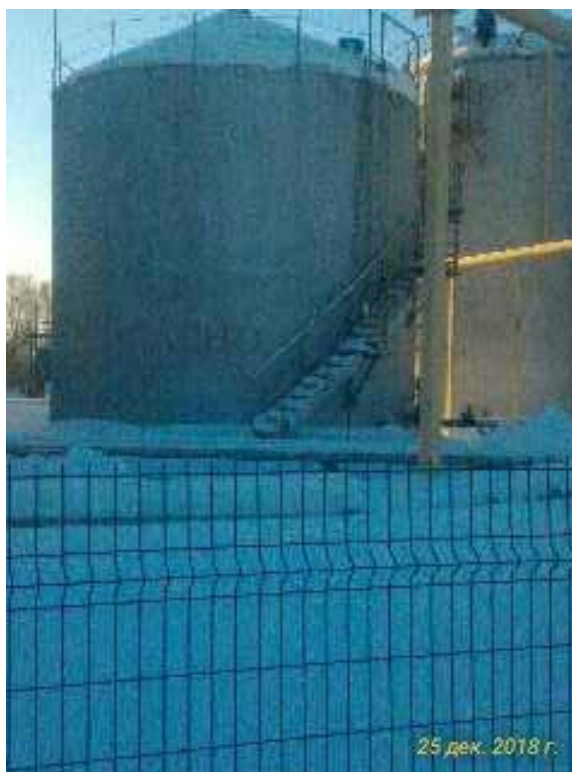
Рисунок 1 - Общий вид резервуара вертикального стального цилиндрического РВС-400
