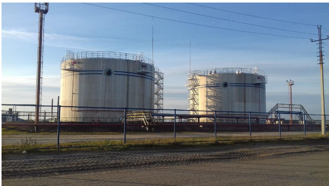
Рисунок 1 - Общий вид резервуаров РВС-3000
