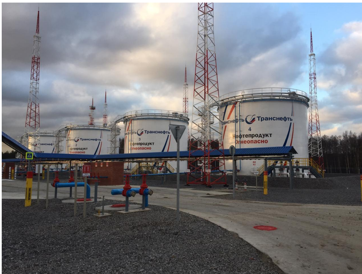
Рисунок 1 - Общий вид резервуаров РВС-2000
