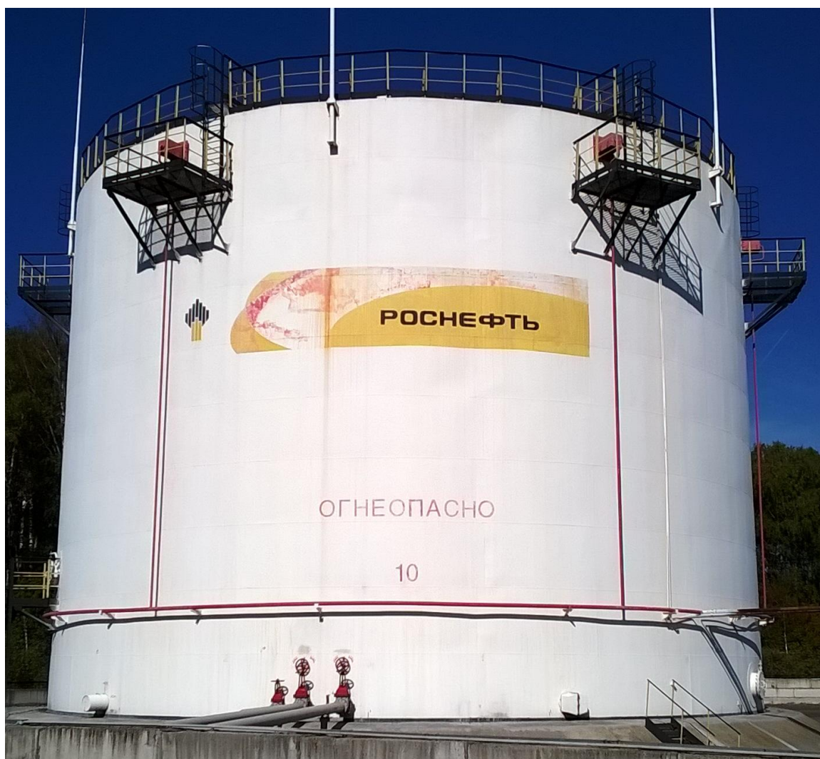
Рисунок 2 - Общий вид резервуара стального вертикального цилиндрического РВСП-5000
