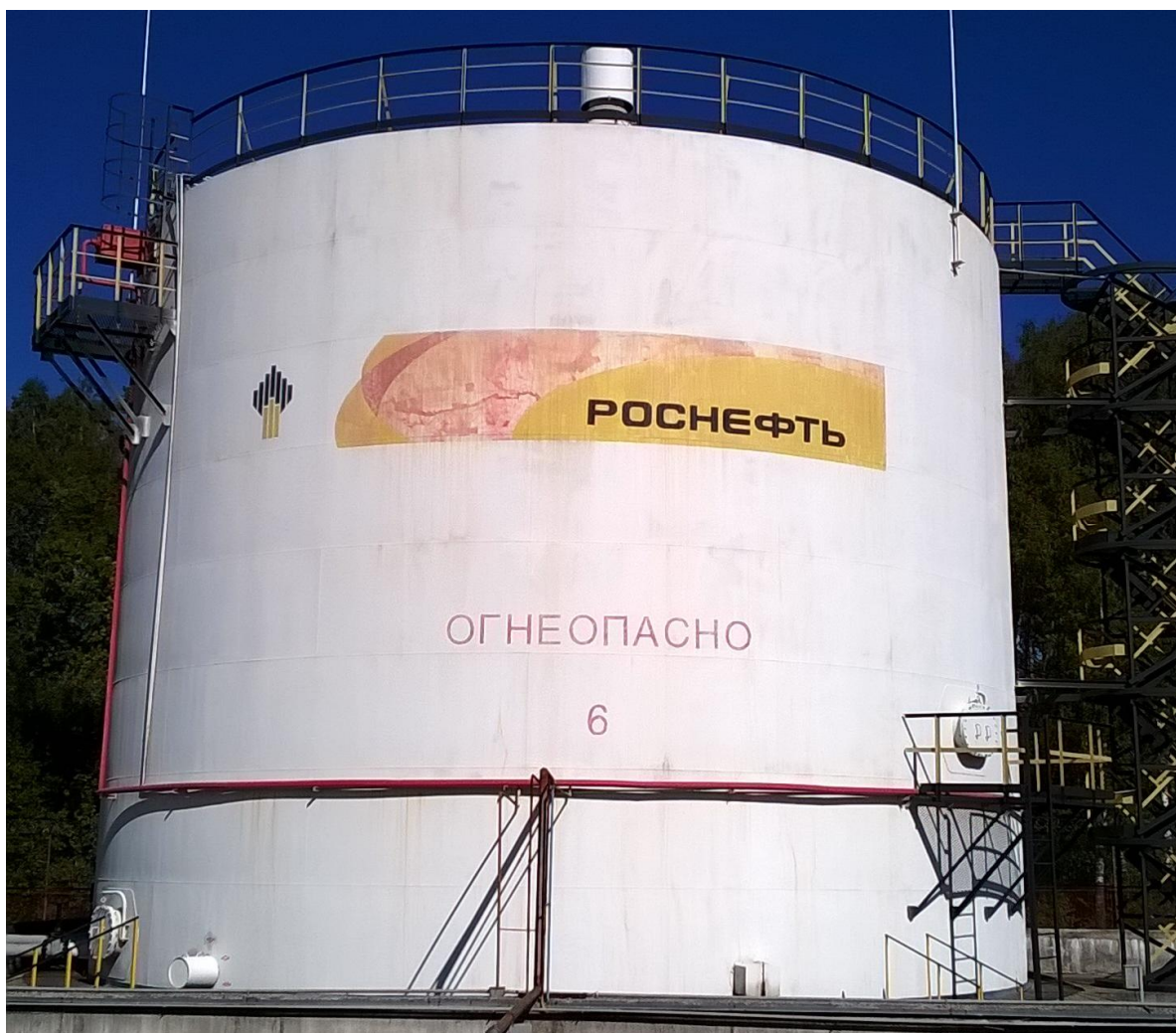
Рисунок 1 - Общий вид резервуара стального вертикального цилиндрического РВСП-2000
