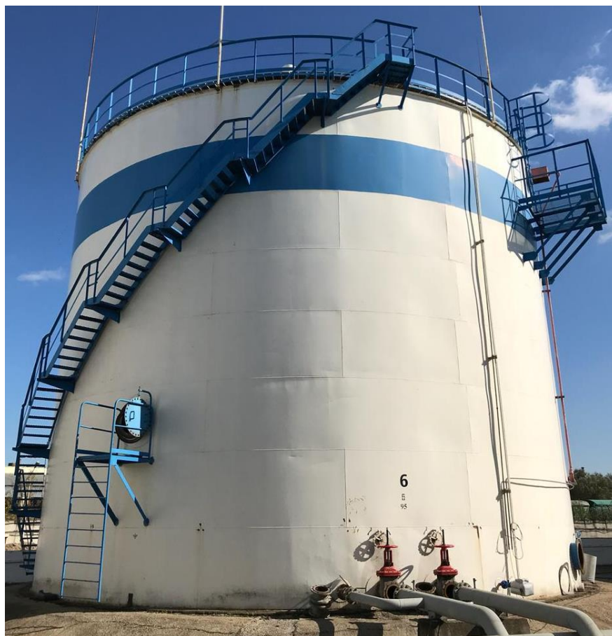
Рисунок 2 - Общий вид резервуара стального вертикального цилиндрического РВСП-2000
