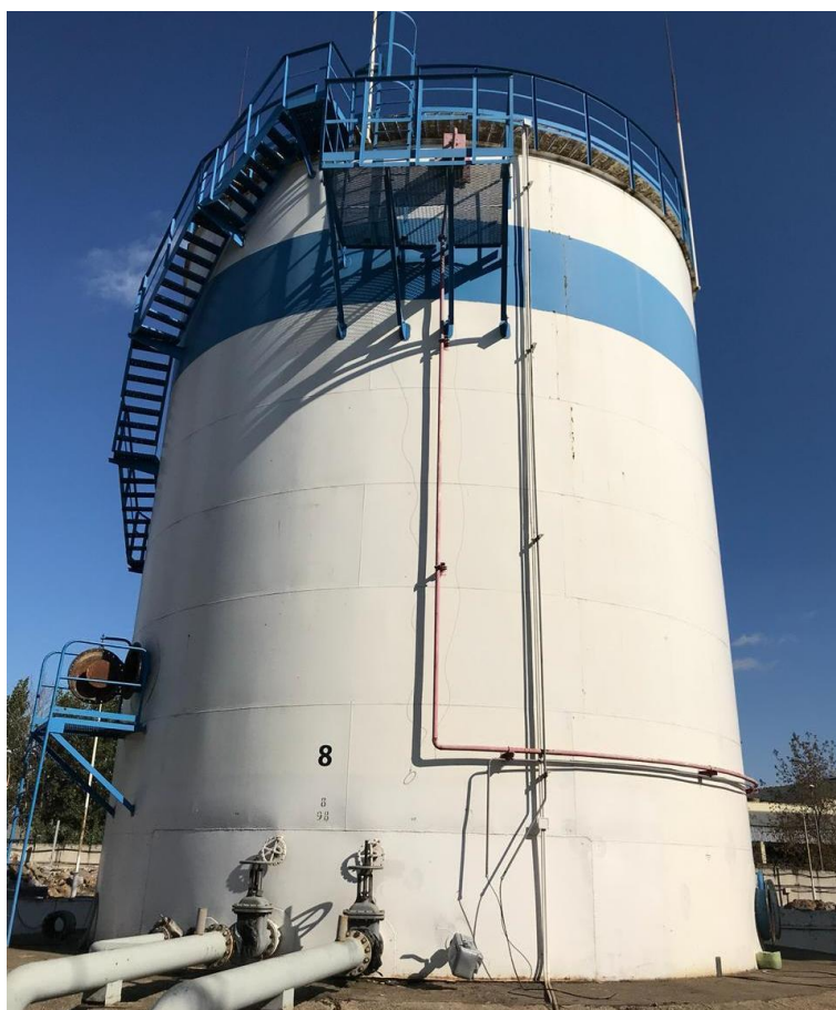
Рисунок 1 - Общий вид резервуара стального вертикального цилиндрического РВСП-1000
