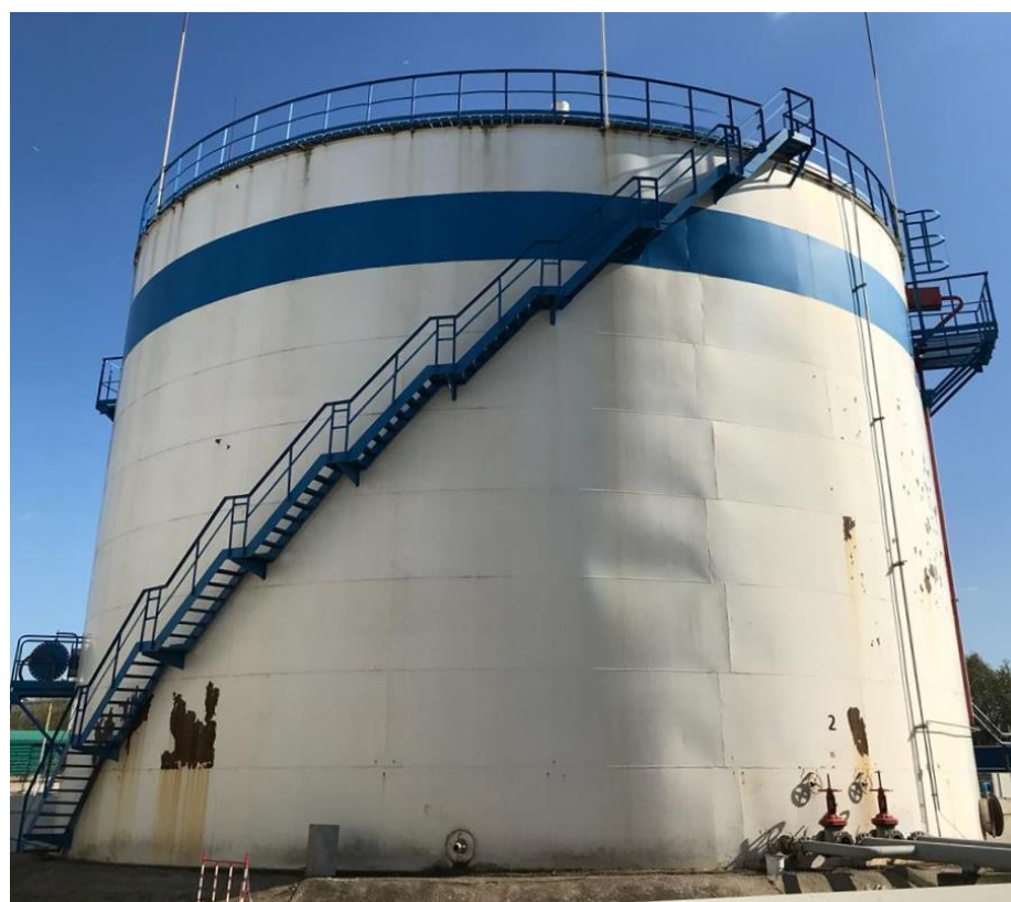
Рисунок 5 - Общий вид резервуара стального вертикального цилиндрического РВСП-4000
