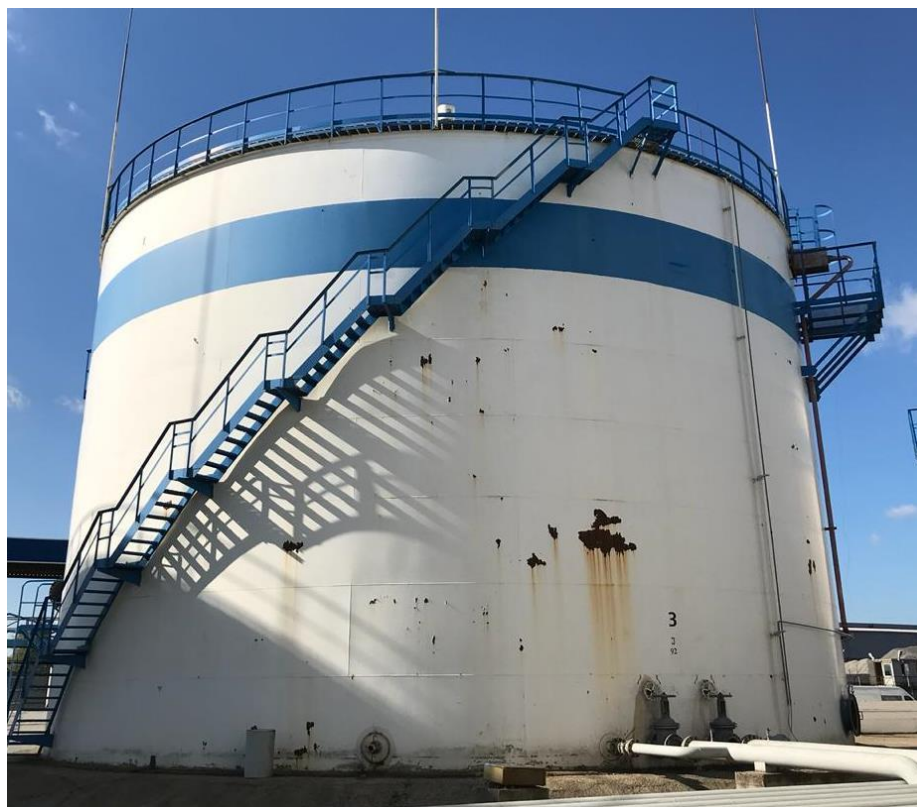
Рисунок 4 - Общий вид резервуара стального вертикального цилиндрического РВСП-3000
