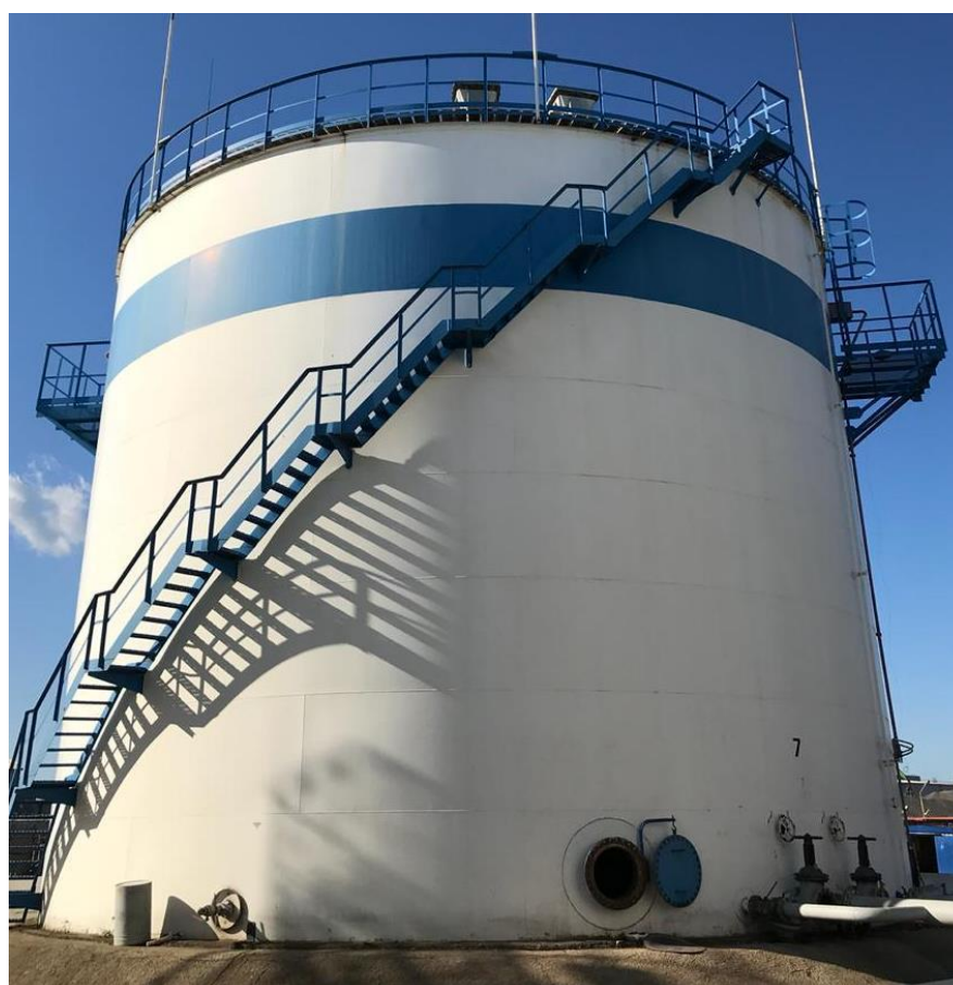
Рисунок 3 - Общий вид резервуара стального вертикального цилиндрического РВС-2000
