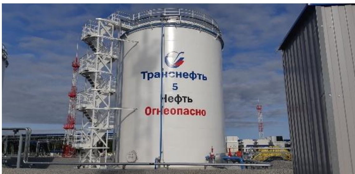
Рисунок 1 - Общий вид резервуара вертикального стального цилиндрического РВС-1000
