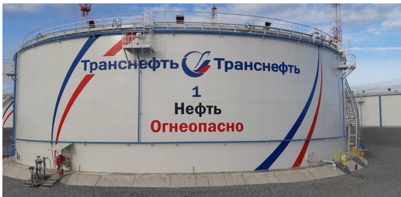
Рисунок 2 - Общий вид резервуара вертикального стального цилиндрического РВСП-20000
