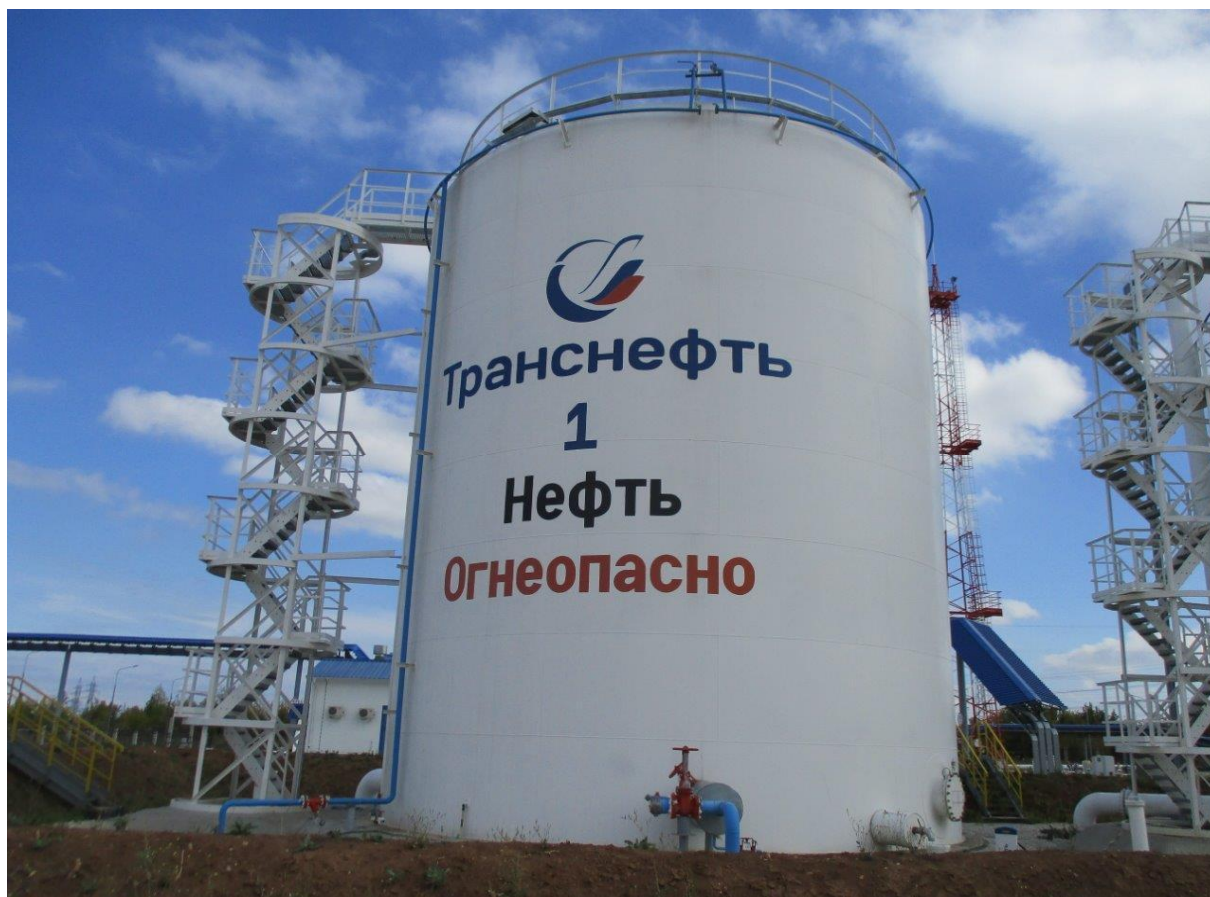
Рисунок 1 - Общий вид резервуара вертикального стального цилиндрического РВС-1000
