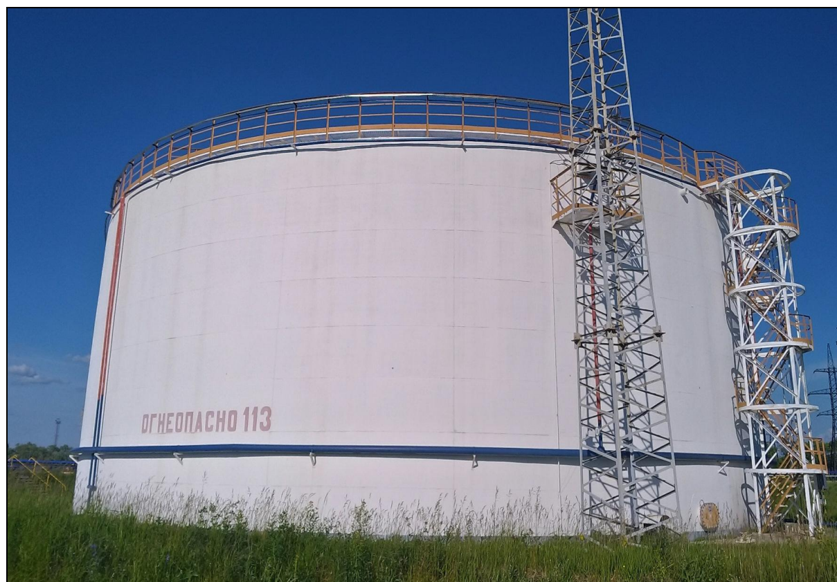
Рисунок 3 - Общий вид резервуаров вертикальных стальных цилиндрических РВС-10000
