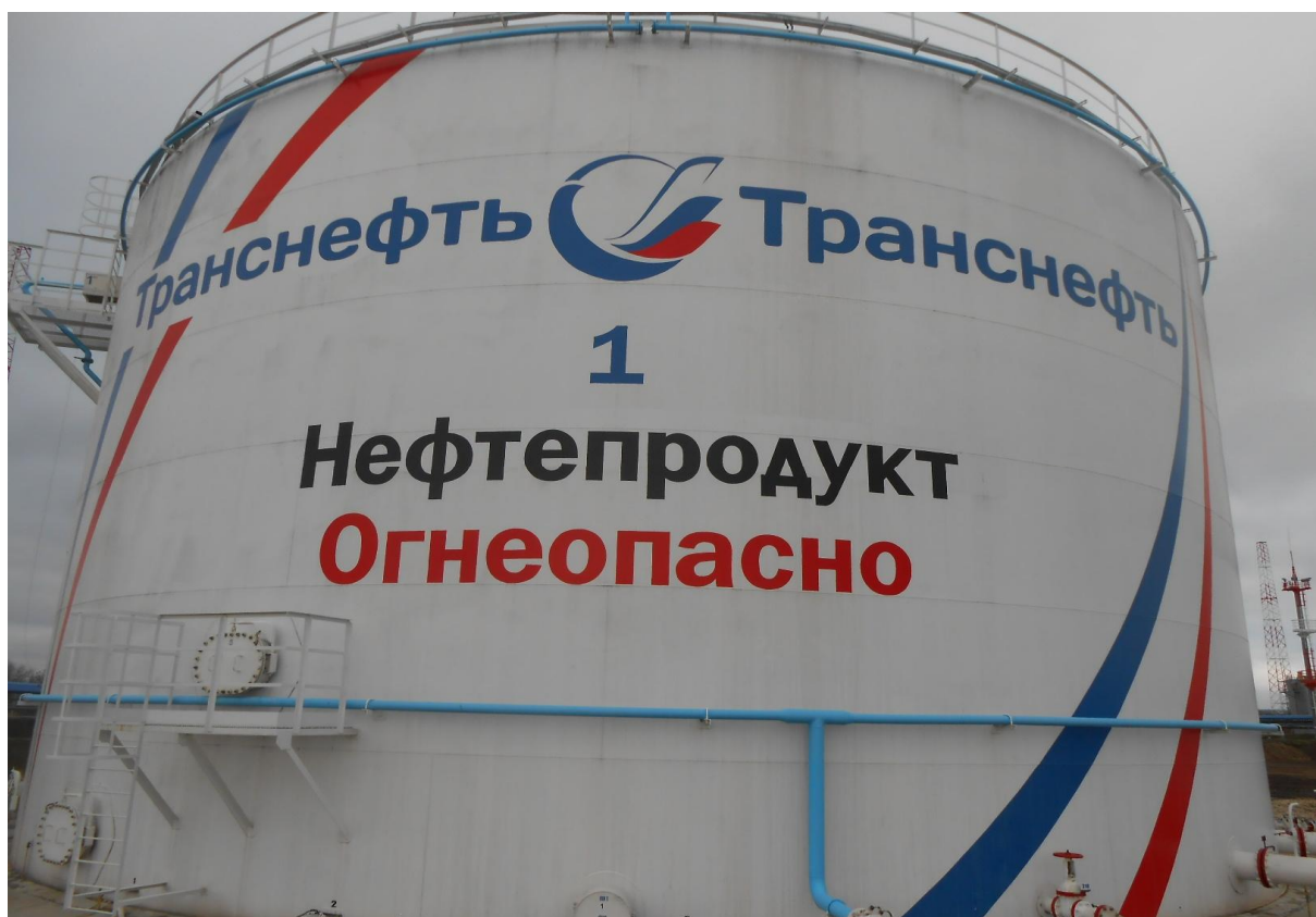
Рисунок 2 - Общий вид резервуаров вертикальных стальных цилиндрических РВС-5000
