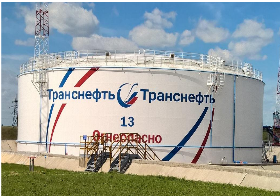
Рисунок 6 - Общий вид резервуаров вертикальных стальных цилиндрических РВСП-20000
