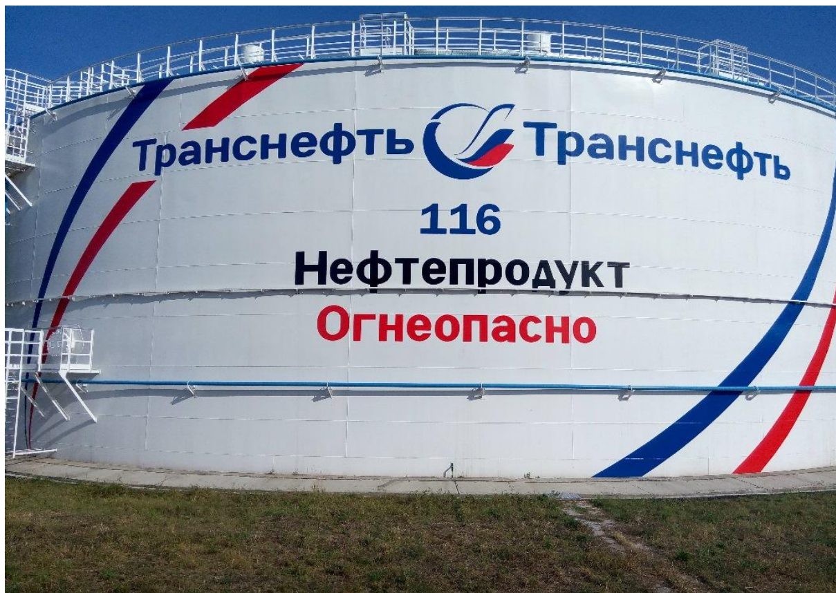
Рисунок 4 - Общий вид резервуаров вертикальных стальных цилиндрических РВС-20000
