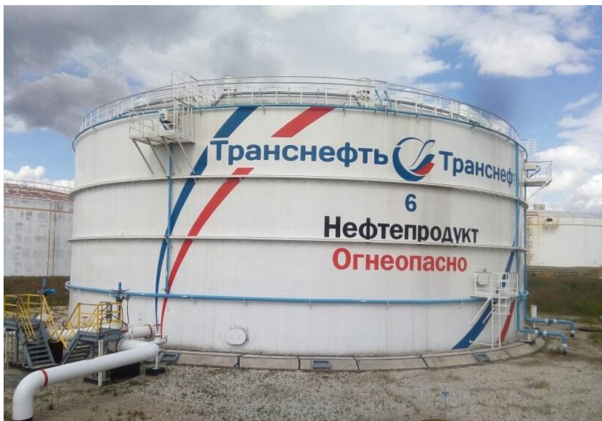
Рисунок 5 - Общий вид резервуаров вертикальных стальных цилиндрических РВСП-10000
