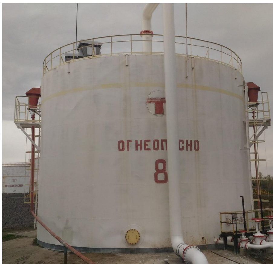
Рисунок 1 - Общий вид резервуаров вертикальных стальных цилиндрических РВС-1000
