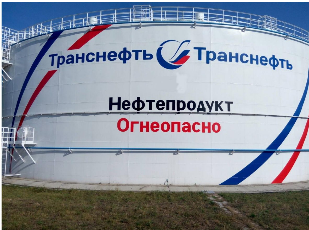
Рисунок 1 - Общий вид резервуаров вертикальных стальных цилиндрических РВС-20000
