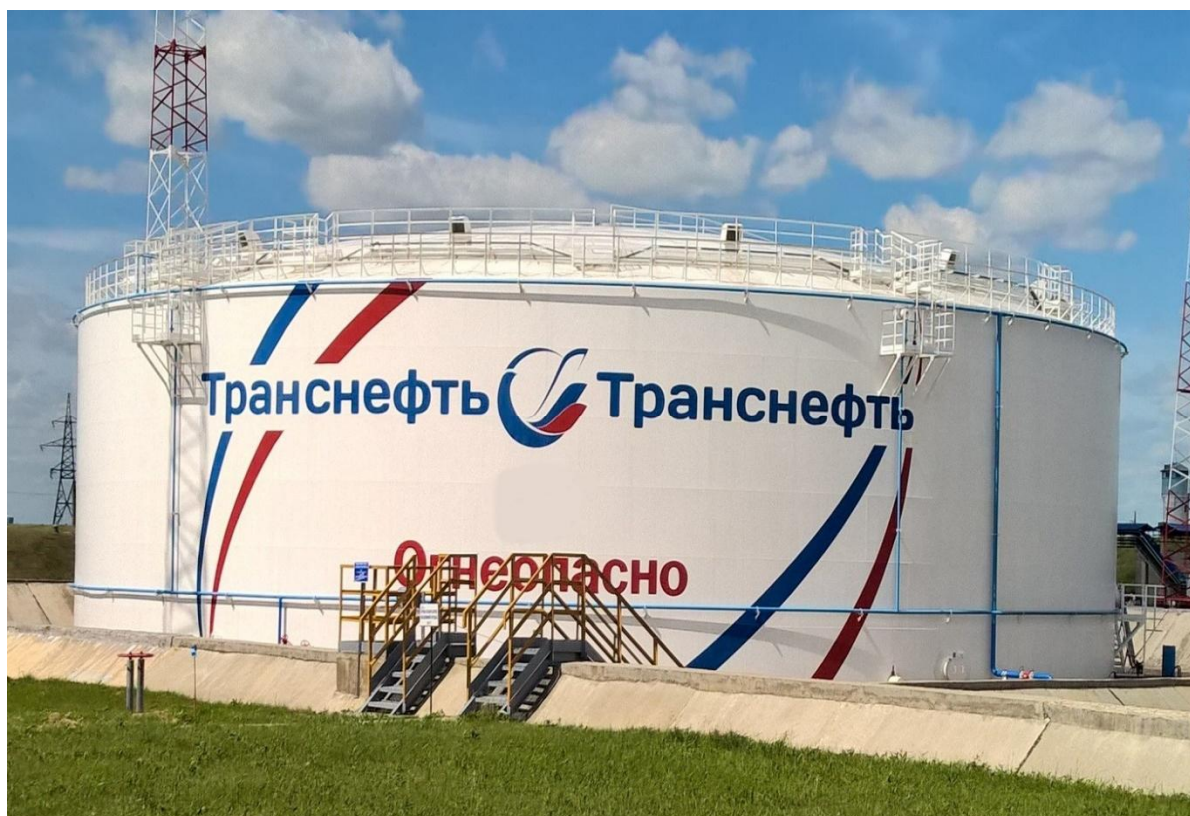
Рисунок 2 - Общий вид резервуаров вертикальных стальных цилиндрических РВСП-20000
