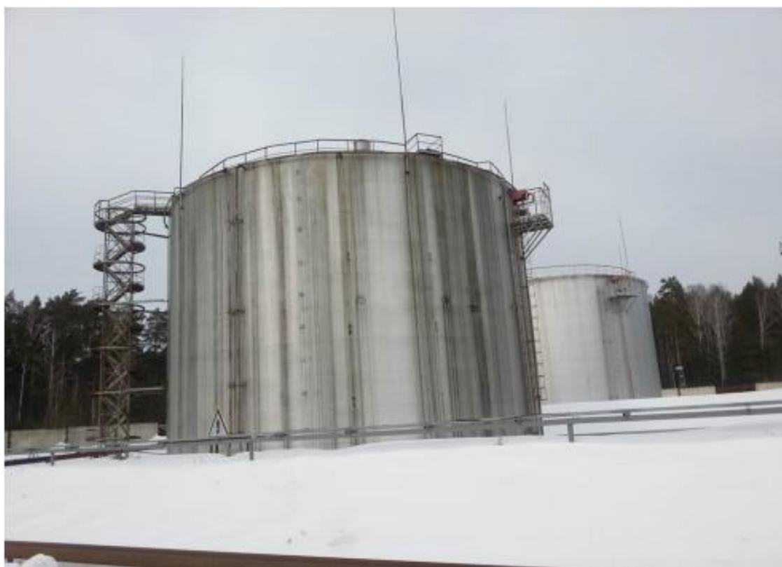
Рисунок 3 - Общий вид резервуара вертикального стального цилиндрического РВС-5000
