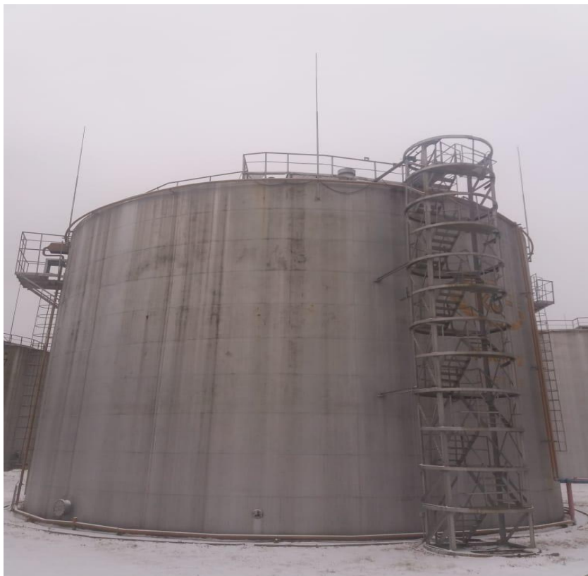
Рисунок 4 - Общий вид резервуара вертикального стального цилиндрического РВСП-5000
