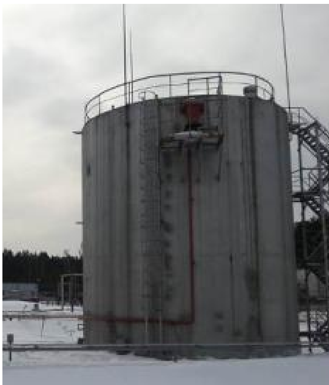
Рисунок 1 - Общий вид резервуара вертикального стального цилиндрического РВС-1000
