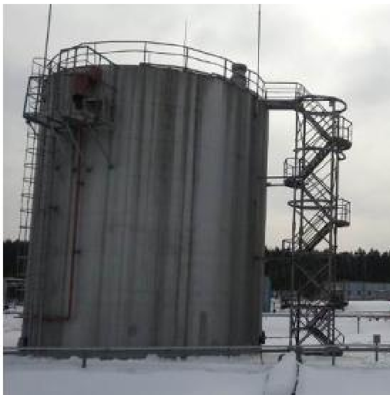
Рисунок 2 - Общий вид резервуара вертикального стального цилиндрического РВСП-1000
