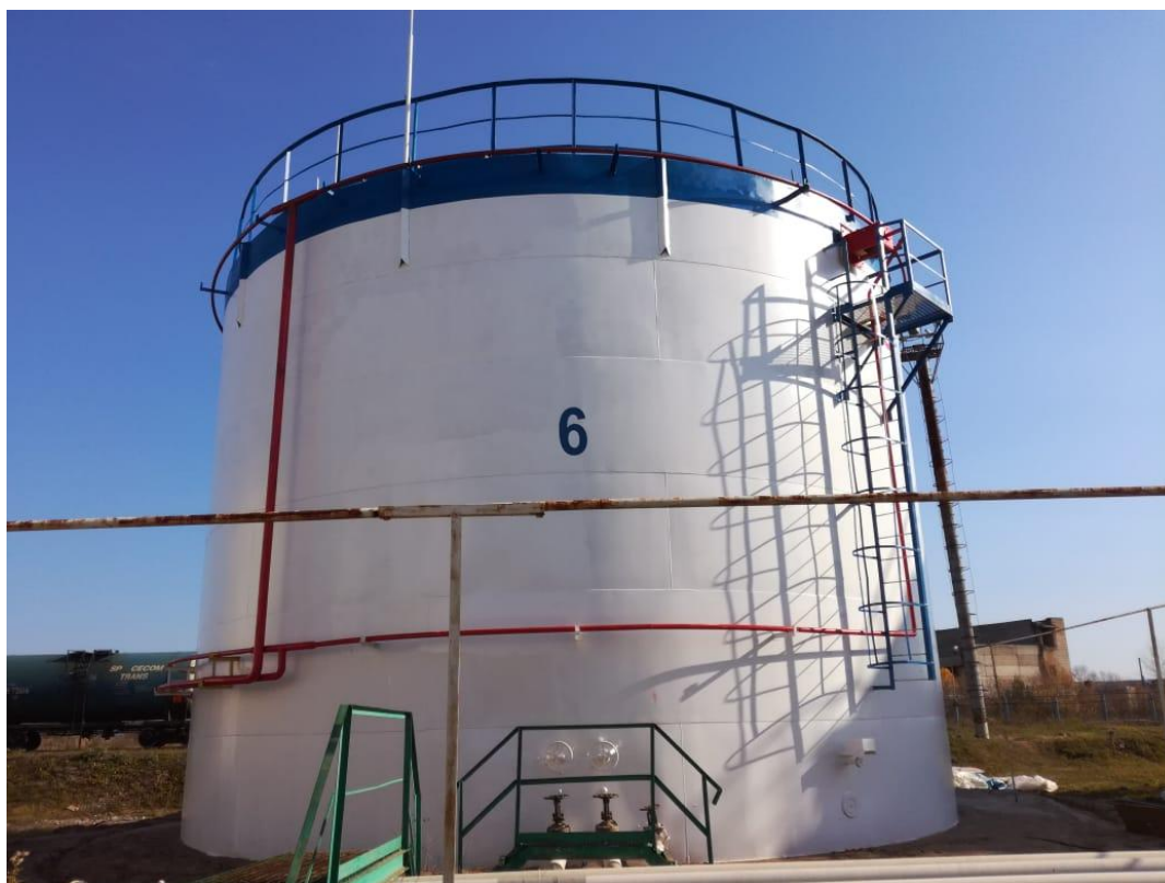
Рисунок 1 - Общий вид резервуара вертикального стального цилиндрического РВС-1000
