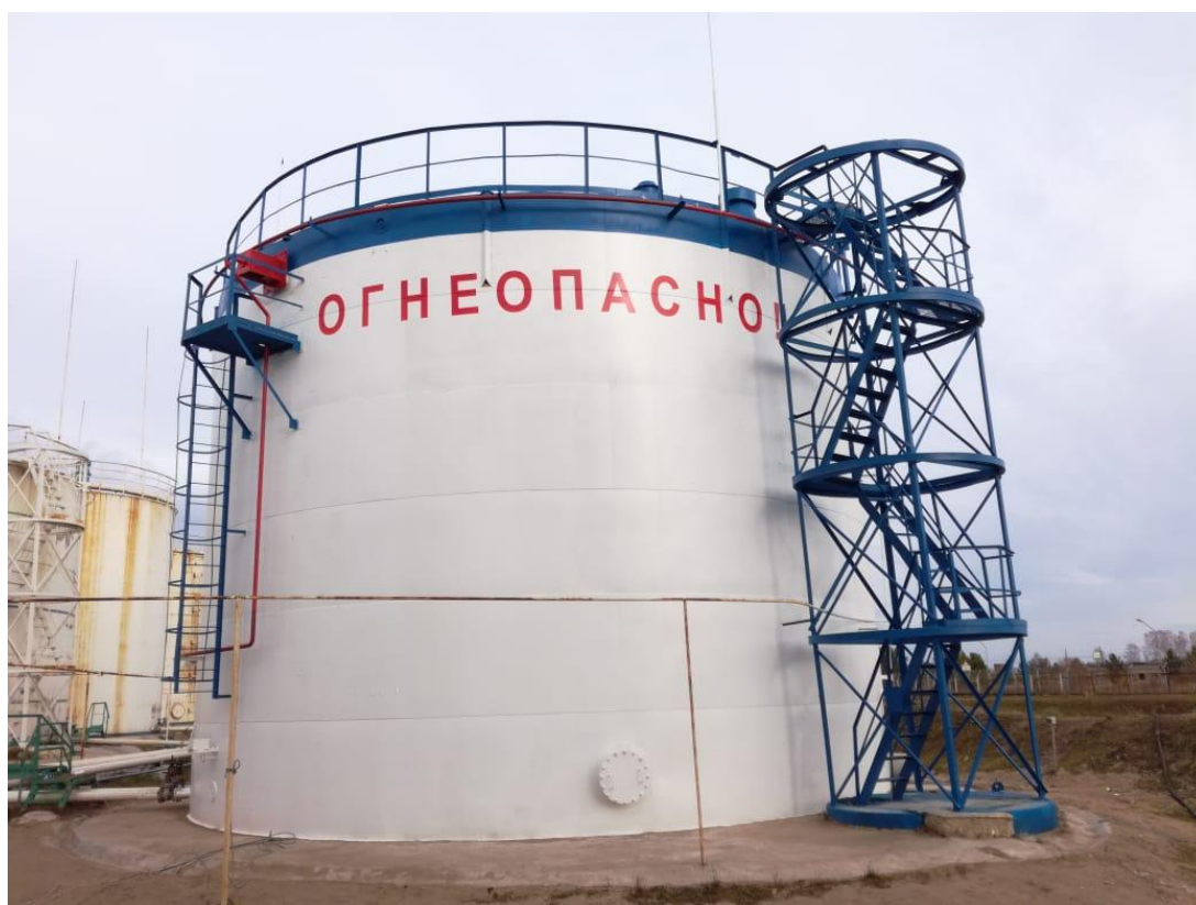
Рисунок 2 - Общий вид резервуара вертикального стального цилиндрического РВСП-1000
