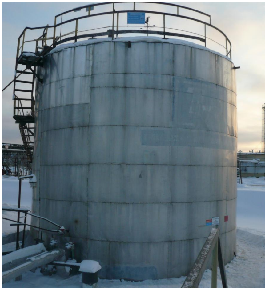
Рисунок 1 - Общий вид резервуара стального вертикального цилиндрического РВС-400
