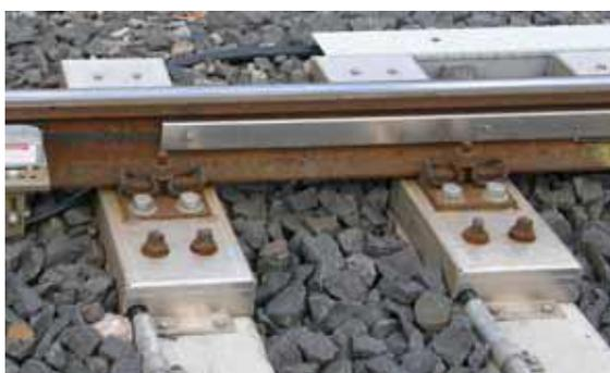
Общий вид установки датчиков RPC-120T и датчиков в рельс вместе защитой
