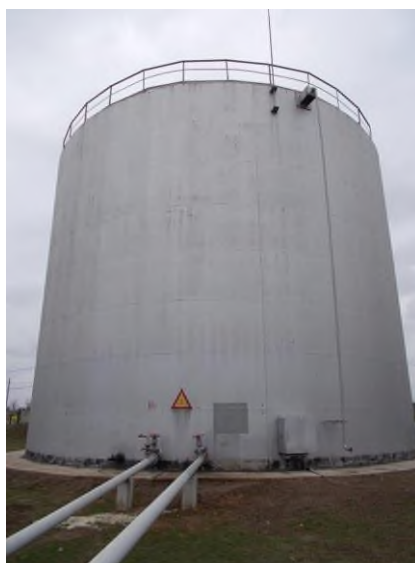
Рисунок 1 – Общий вид резервуаров стальных вертикальных цилиндрических РВС-2000
