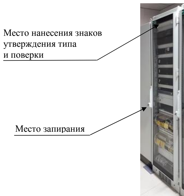
Рисунок 15 – Места расположения знаков утверждения типа и поверки и запираания стойки приборной АИИС
