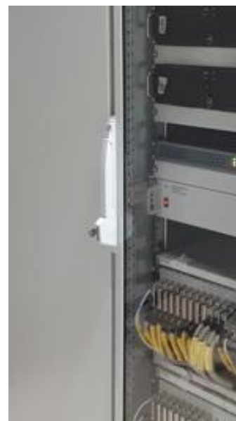
Рисунок 16 – Замок двери стойки приборной АИИС. Вид внешний
