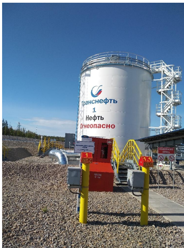
Рисунок 1 - Общий вид резервуара вертикального стального цилиндрического РВС-1000
