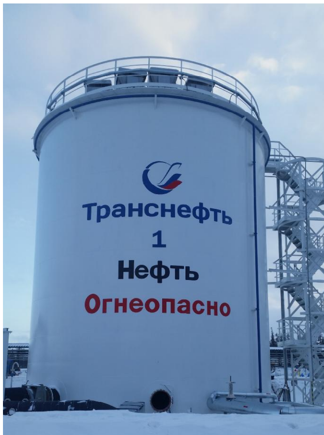
Рисунок 1 - Общий вид резервуаров вертикальных стальных цилиндрических РВС-1000
