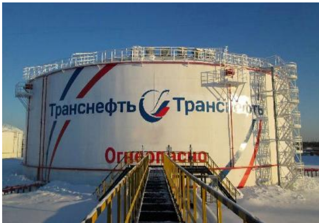
Рисунок 1 - Общий вид резервуара вертикального стального цилиндрического РВС-20000
