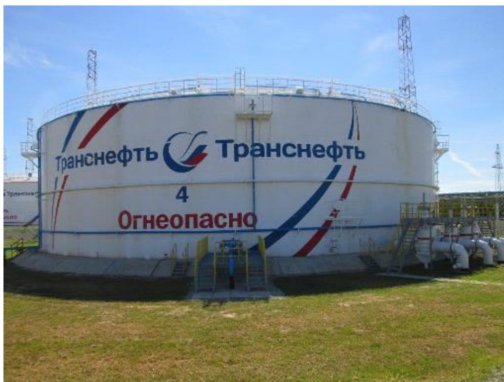
Рисунок 2 - Общий вид резервуара вертикального стального цилиндрического РВСП-20000
