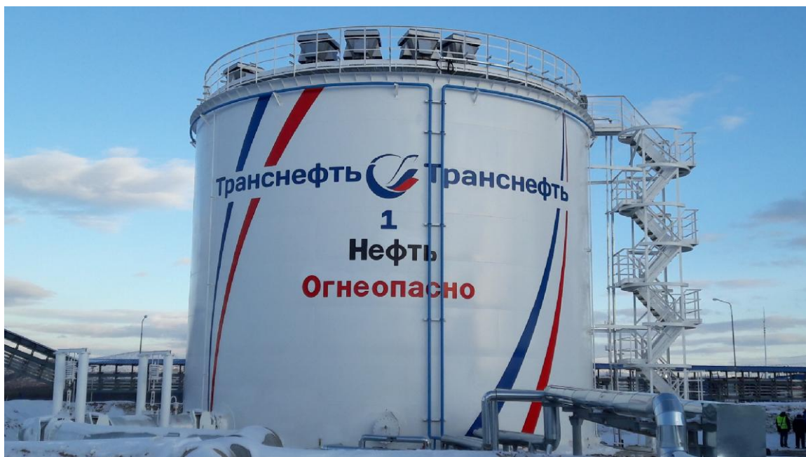
Рисунок 1 - Общий вид резервуара вертикального стального цилиндрического РВС-2000
