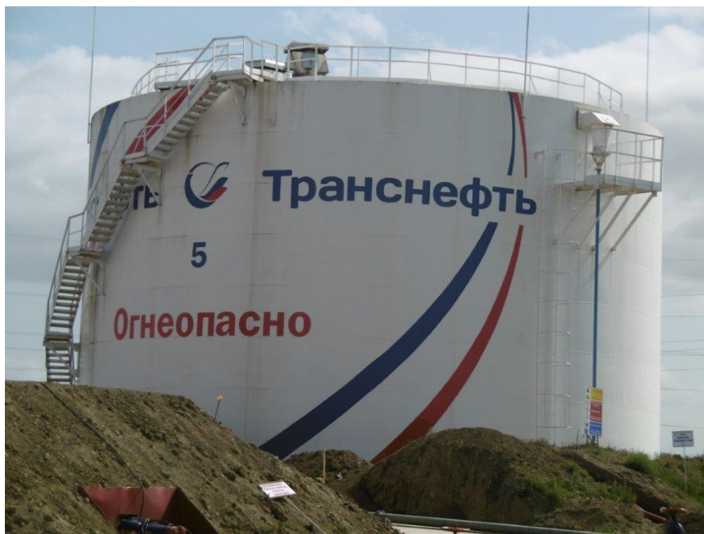
Рисунок 1 - Общий вид резервуара вертикального стального цилиндрического РВС-3000
