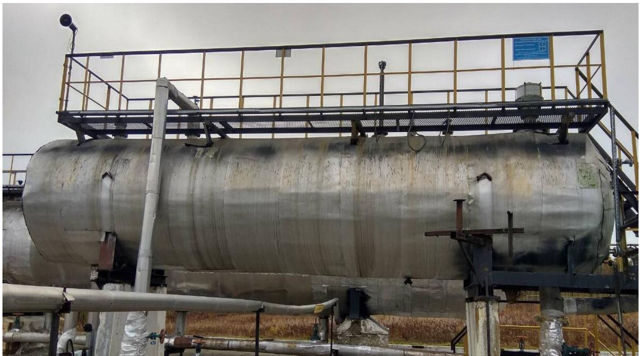
Рисунок 1 - Общий вид резервуара стального горизонтального цилиндрического РГС-50
