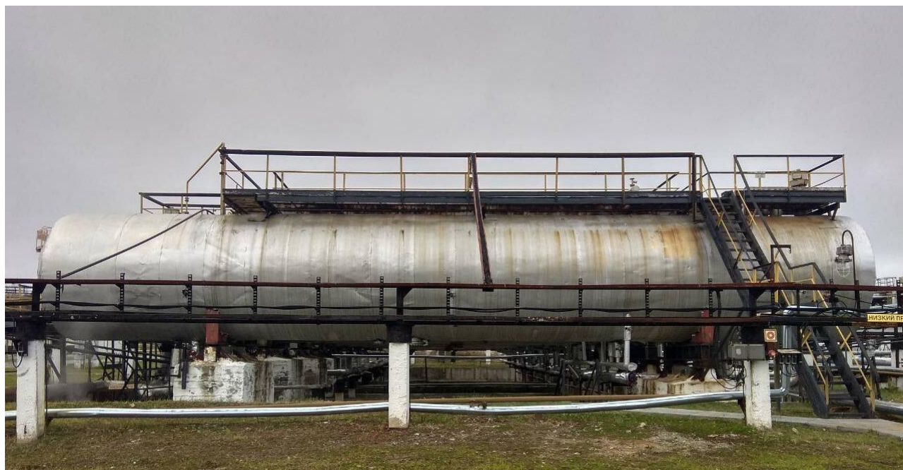
Рисунок 1 - Общий вид резервуара стального горизонтального цилиндрического РГС-200
