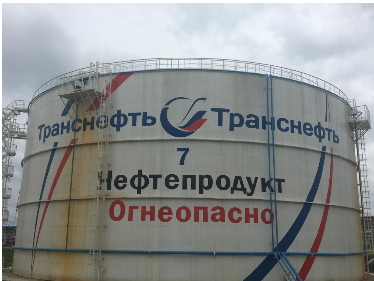
Рисунок 2 - Общий вид резервуара вертикального стального цилиндрического РВС-20000
