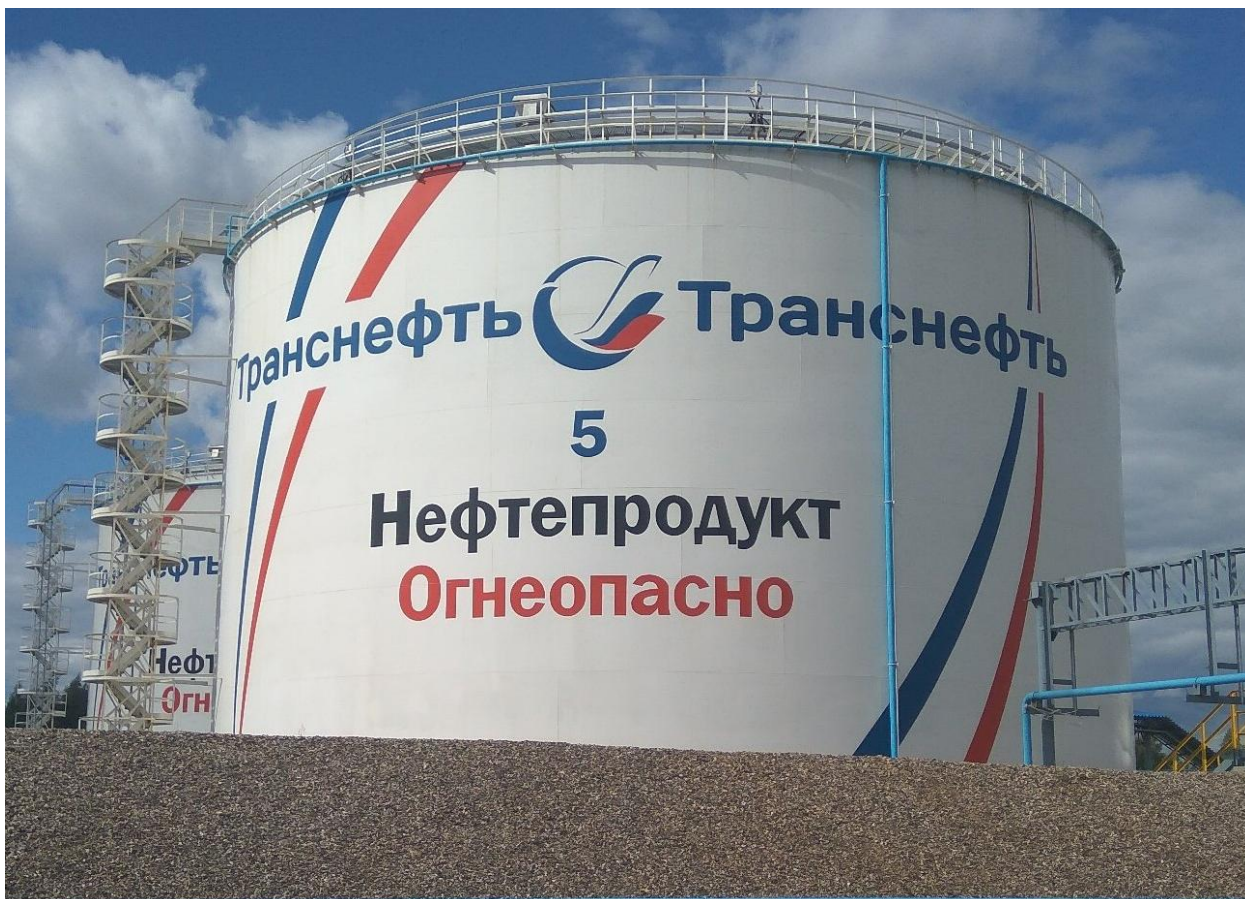
Рисунок 1 - Общий вид резервуара вертикального стального цилиндрического РВС-10000
