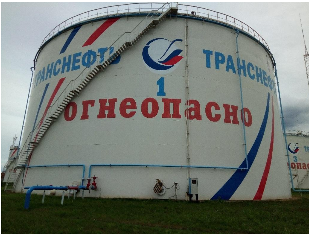
Рисунок 3 - Общий вид резервуара вертикального стального цилиндрического РВСП-20000
