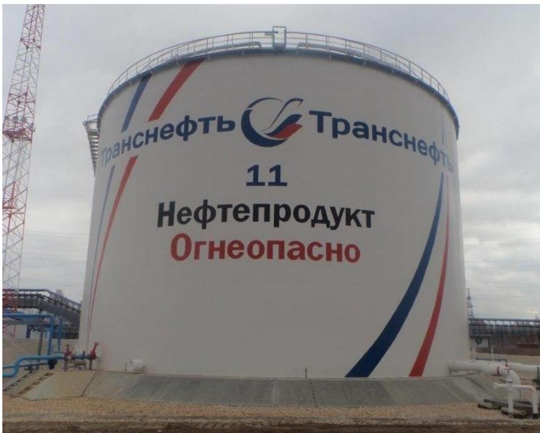
Рисунок 1 - Общий вид резервуара вертикального стального цилиндрического РВС-10000
