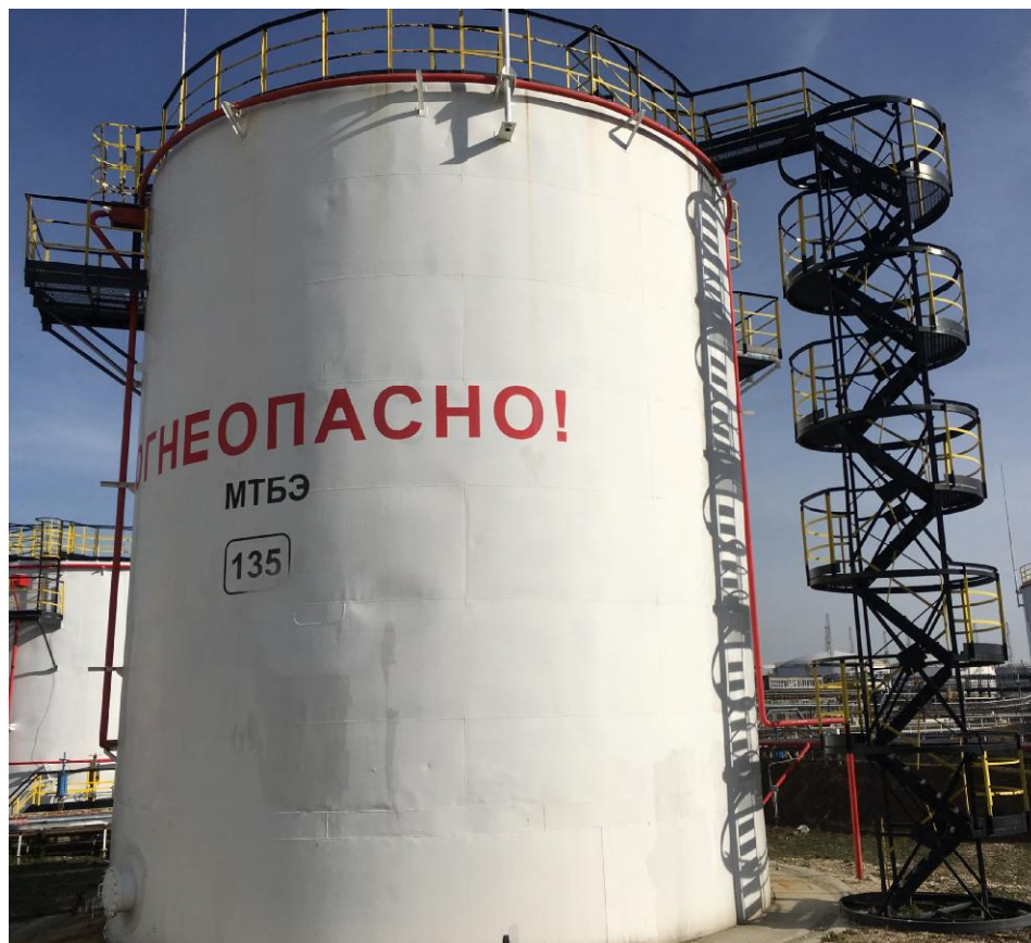
Рисунок 1 - Общий вид резервуара стального вертикального цилиндрического РВС-1000
