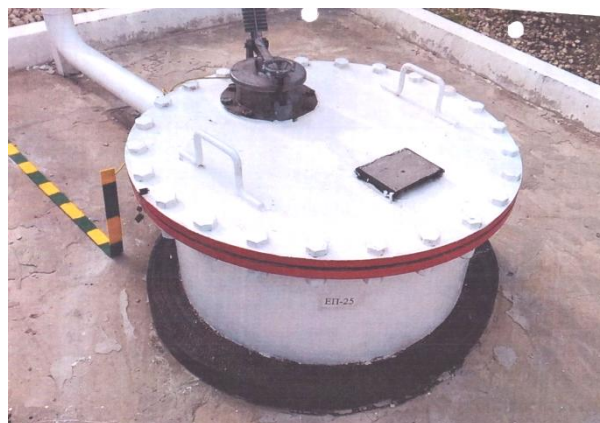
Рисунок 2 - Общий вид резервуара РГС-25 № 52
