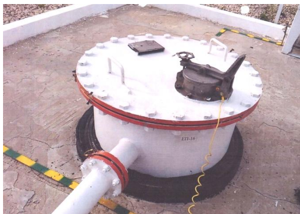
Рисунок 1 - Общий вид резервуара РГС-16 № 33
