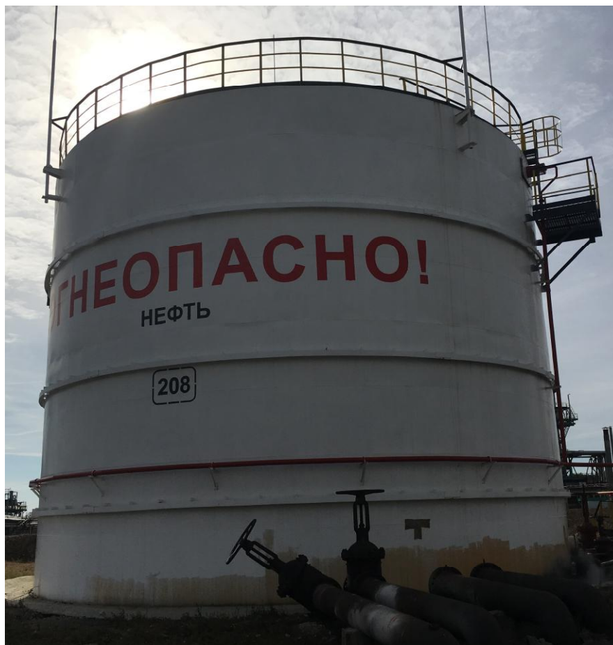
Рисунок 6 - Общий вид резервуара стального вертикального цилиндрического РВС-2000
