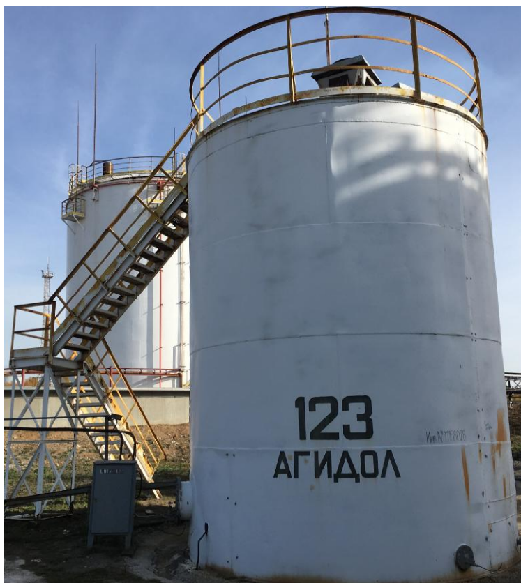
Рисунок 1 - Общий вид резервуара стального вертикального цилиндрического РВС-100
