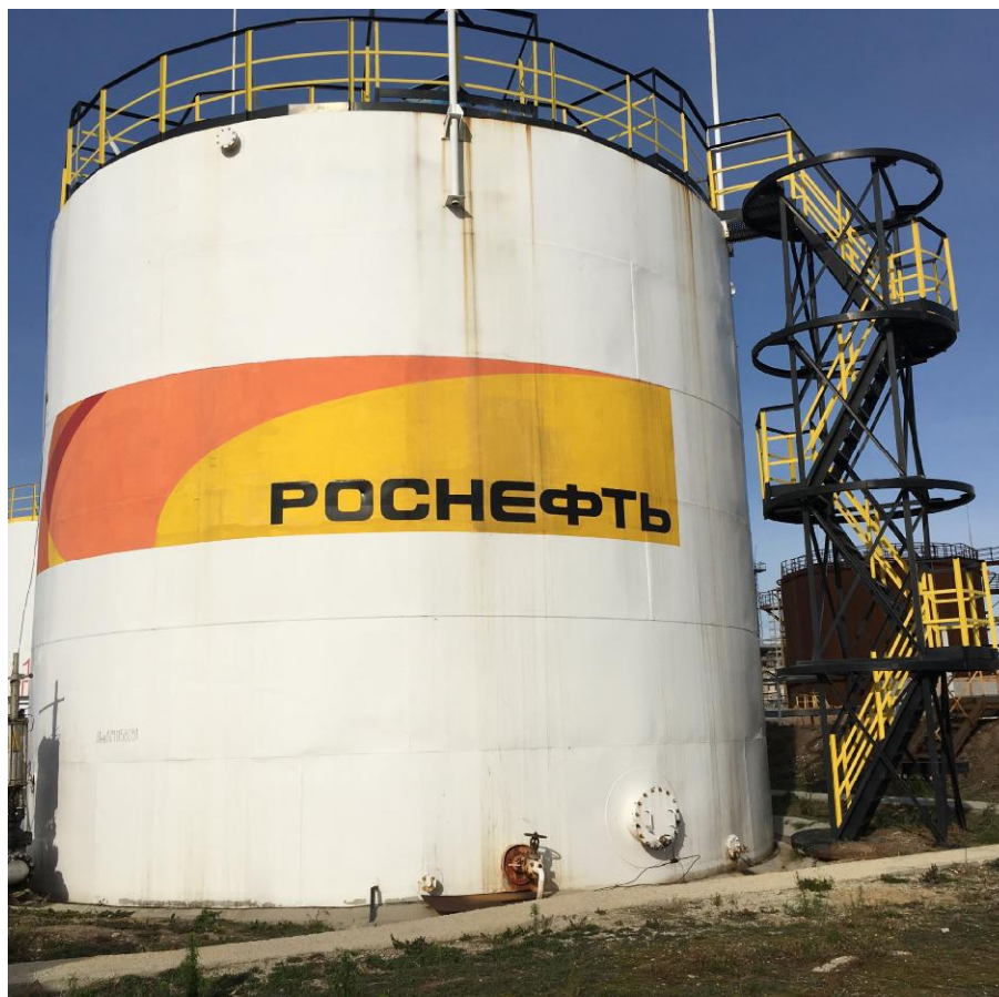
Рисунок 4 - Общий вид резервуара стального вертикального цилиндрического РВС-700
