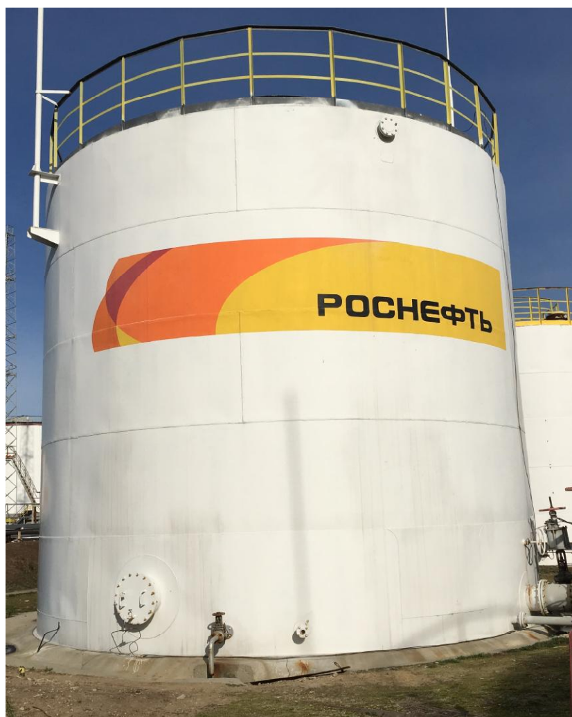
Рисунок 3 - Общий вид резервуара стального вертикального цилиндрического РВС-400
