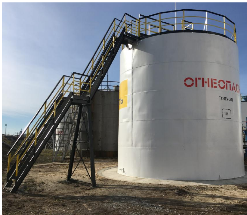
Рисунок 2 - Общий вид резервуара стального вертикального цилиндрического РВС-300
