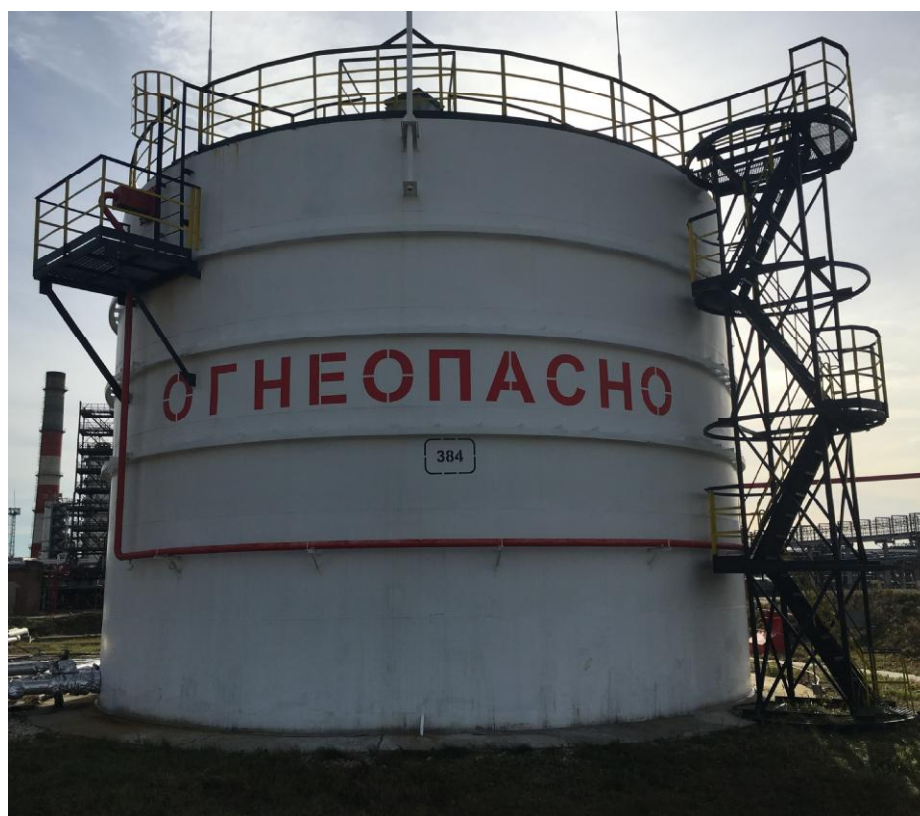
Рисунок 5 - Общий вид резервуара стального вертикального цилиндрического РВС-1000, РВСП-1000
