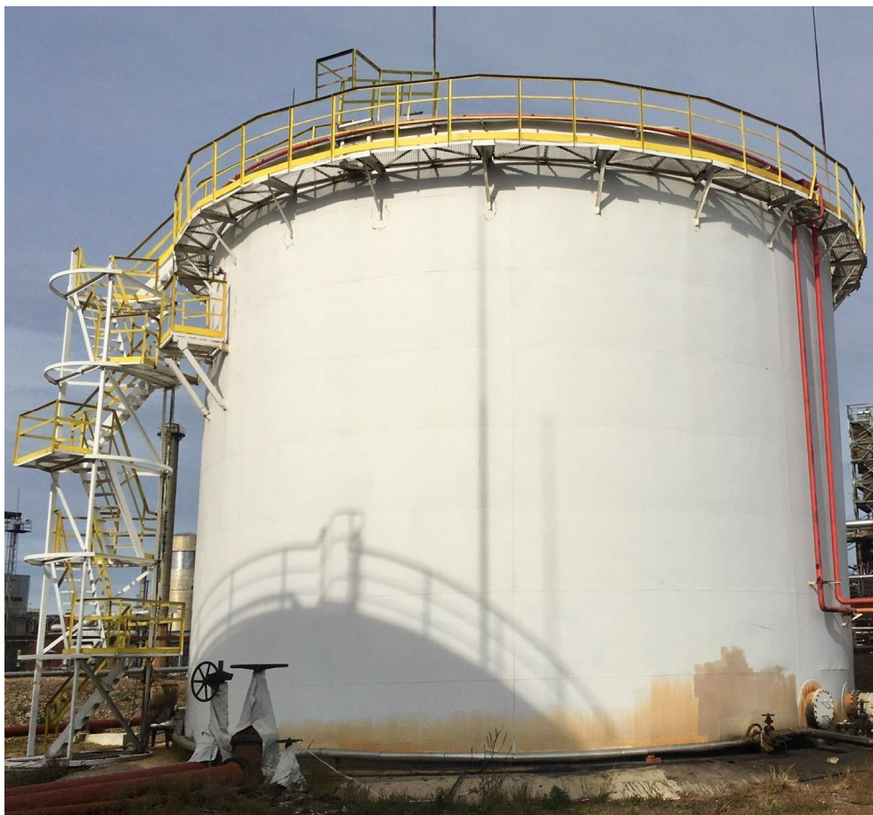
Рисунок 1 - Общий вид резервуара стального вертикального цилиндрического РВС-2000, РВСП-2000
