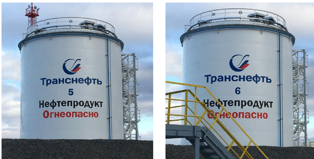
Рисунок 1 - Общий вид резервуаров стальных вертикальных цилиндрических РВС-1000 зав. №№ 5, 6
