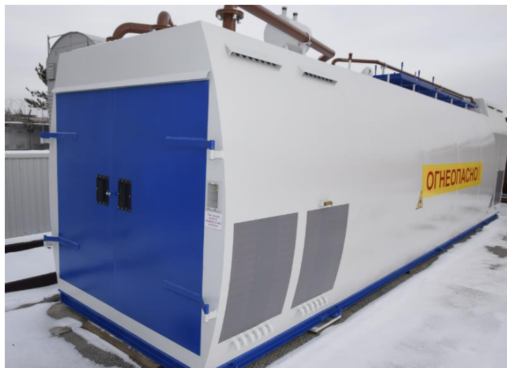
Рисунок 1 – Внешний вид резервуара стального горизонтального наземного РГСН-20 (5+5+10) в составе контейнерной автозаправочной станции КАЗС-5.2+10.1Д
