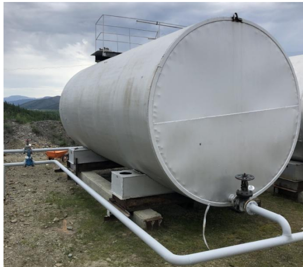
Рисунок 1 - Общий вид резервуара стального горизонтального цилиндрического РГС-75
