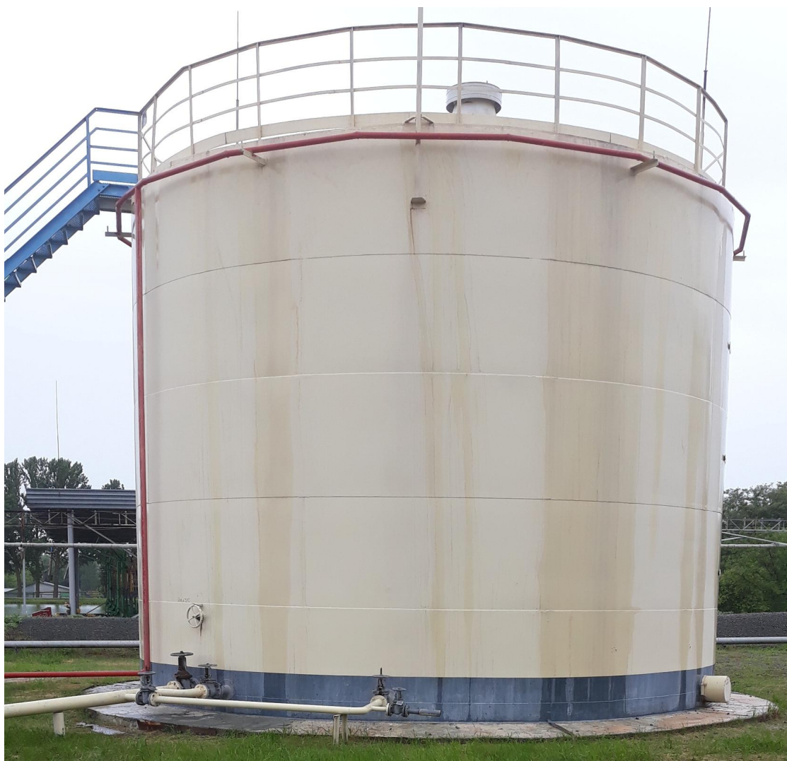
Рисунок 1 - Резервуар стальной вертикальный цилиндрический с понтоном РВСП-400
