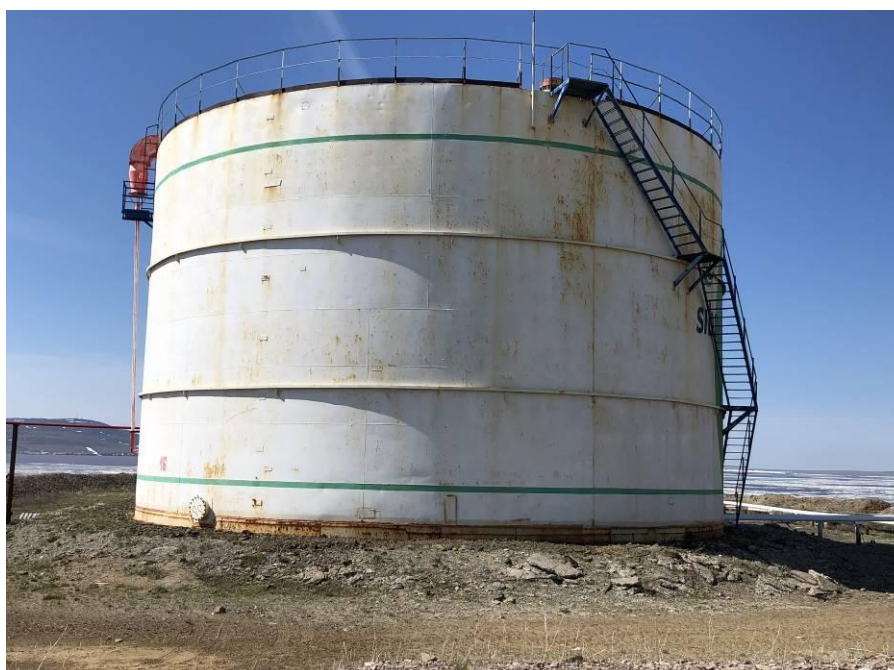
Рисунок 4 - Общий вид резервуара РВС-3000
