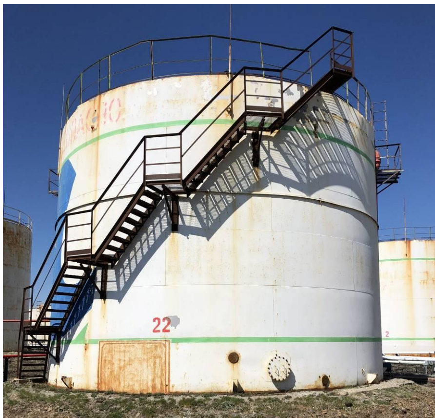
Рисунок 3 - Общий вид резервуара РВС-1000
