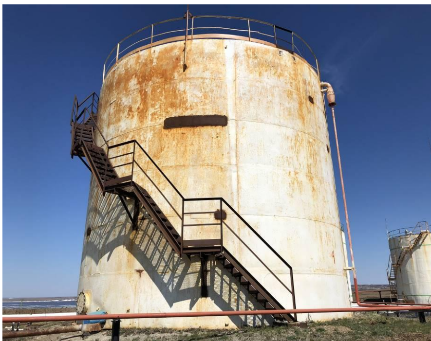
Рисунок 2 - Общий вид резервуара РВС-700
