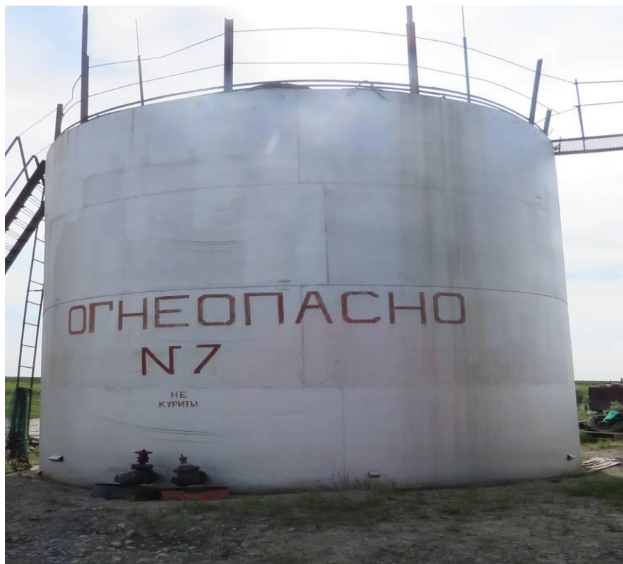
Рисунок 1 - Общий вид резервуара РВС-200
