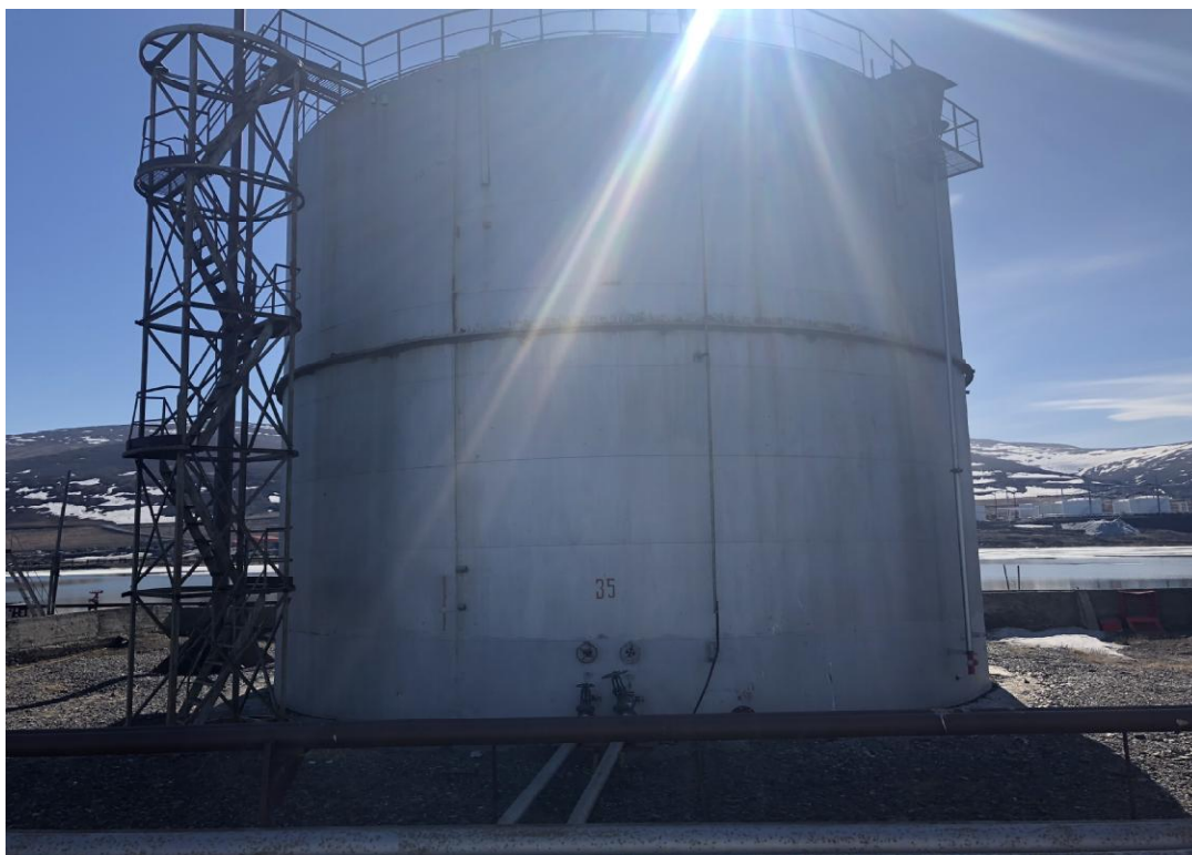
Рисунок 2 - Общий вид резервуара РВС-2000
