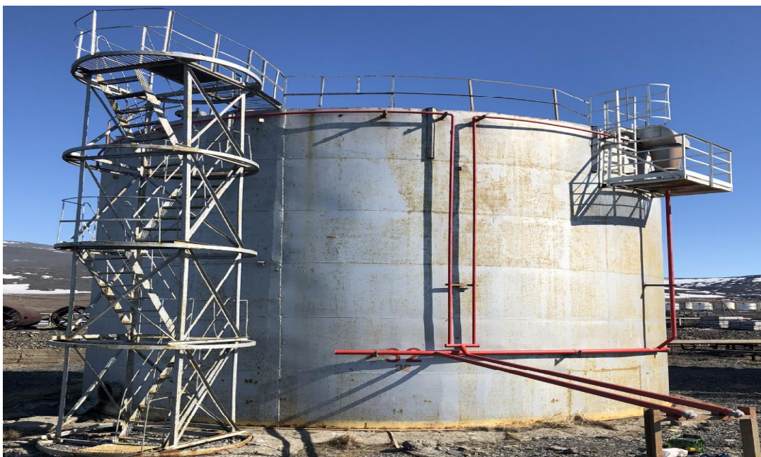
Рисунок 1 - Общий вид резервуара РВС-1000
