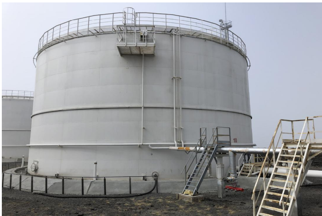
Рисунок 4 - Общий вид резервуара РВС-5000
