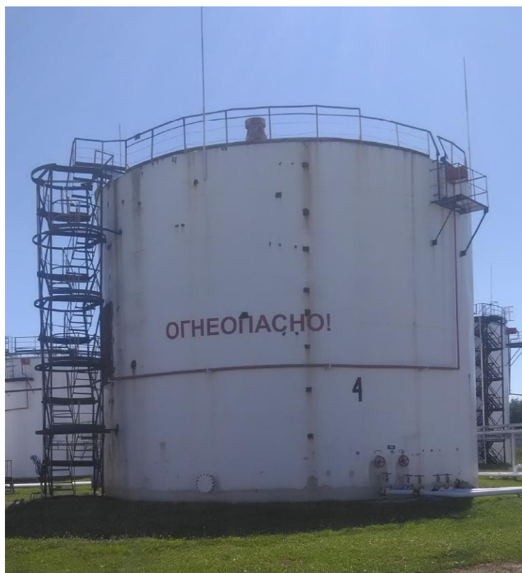
Рисунок 2 - Общий вид резервуара РВС-2000 № 4
