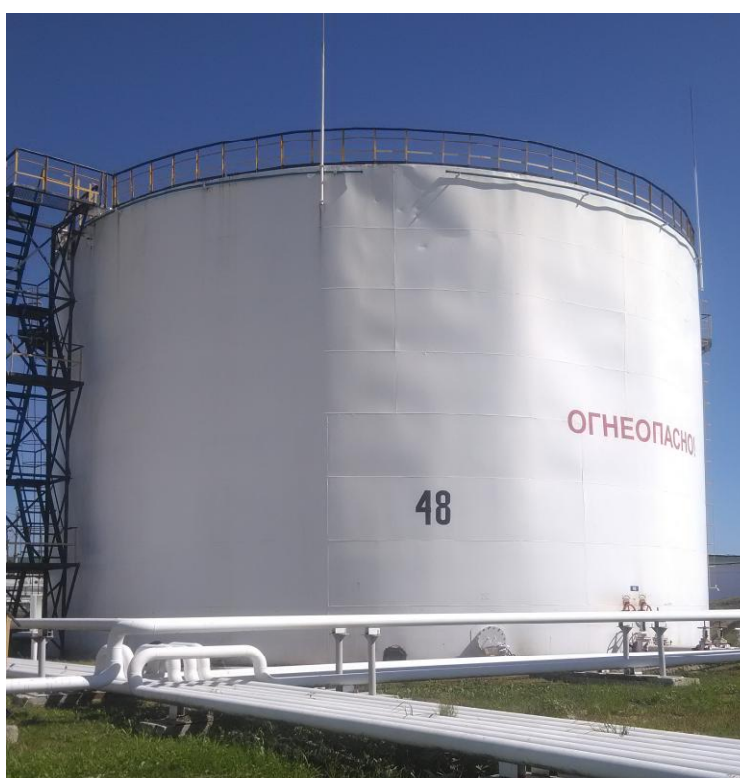
Рисунок 5 - Общий вид резервуара РВС-3000 № 48
