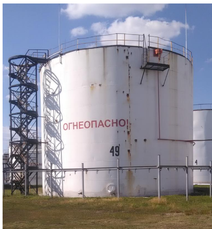
Рисунок 3 - Общий вид резервуара РВС-2000 № 49
