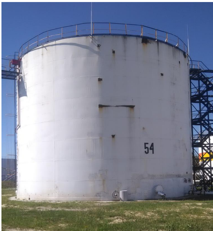
Рисунок 4 - Общий вид резервуара РВС-2000 № 54
