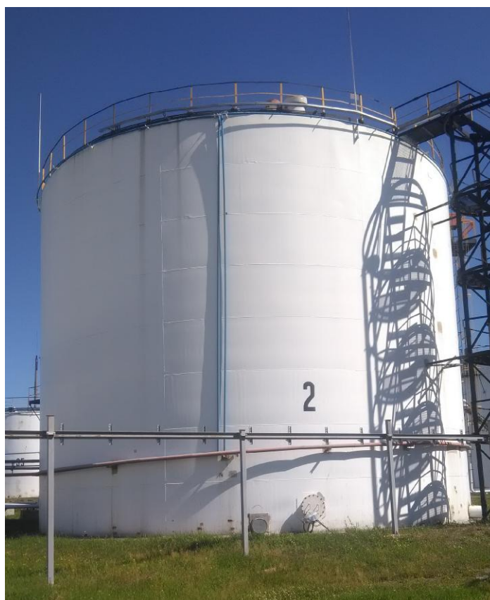
Рисунок 1 - Общий вид резервуара РВС-2000 № 2
