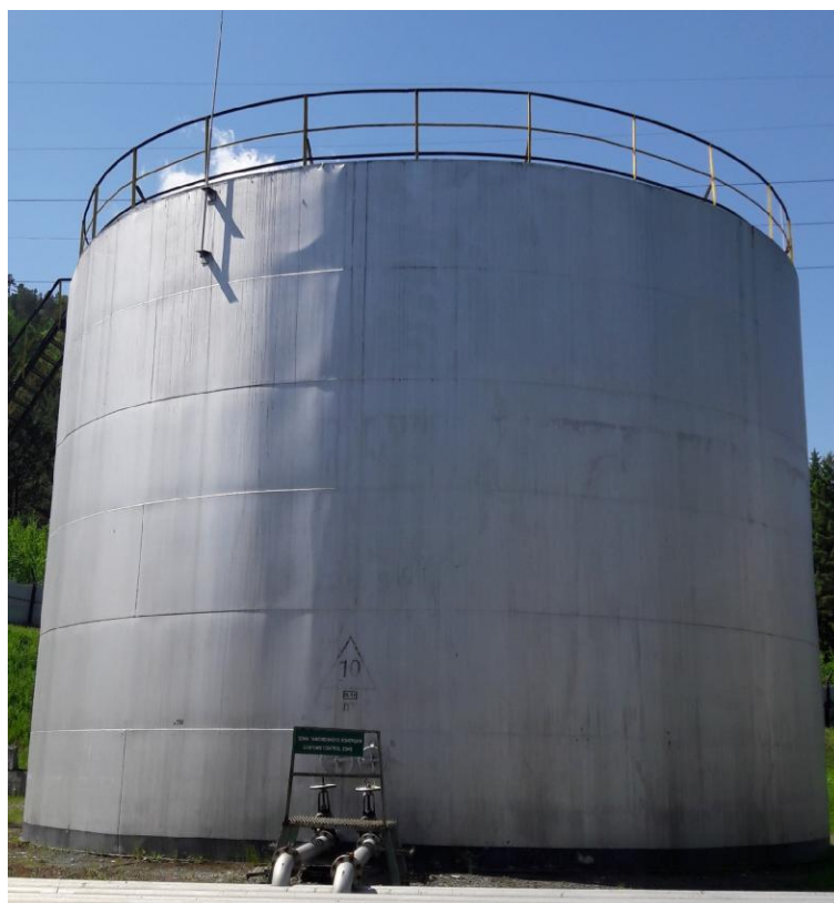
Рисунок 3 - Общий вид резервуара стального вертикального цилиндрического РВС-1000
