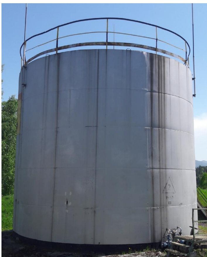
Рисунок 1 - Общий вид резервуара стального вертикального цилиндрического РВС-400
