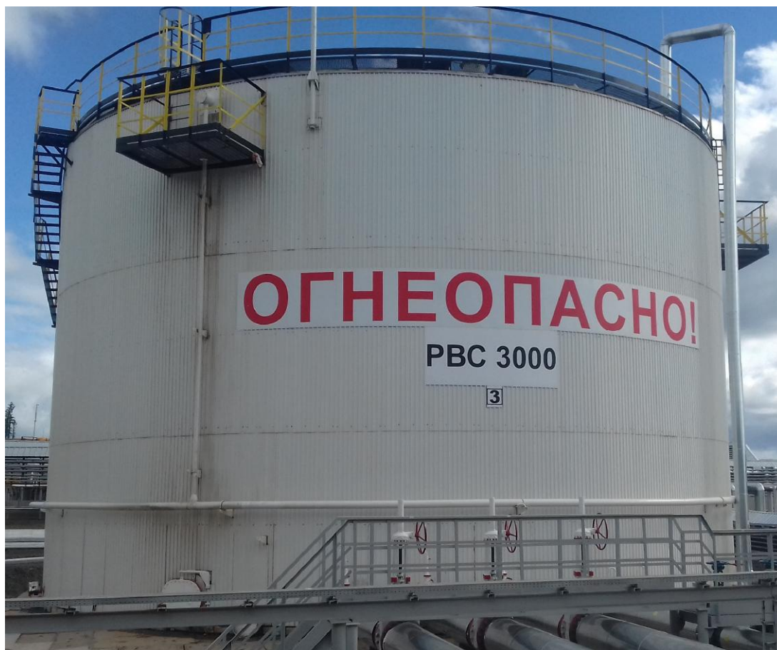
Рисунок 1 - Общий вид резервуара стального вертикального цилиндрического РВС-3000
