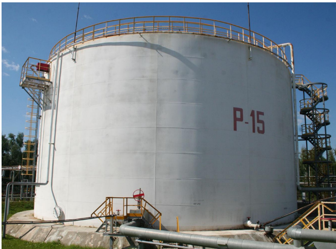
Рисунок 1 - Общий вид резервуара РВС-5000
