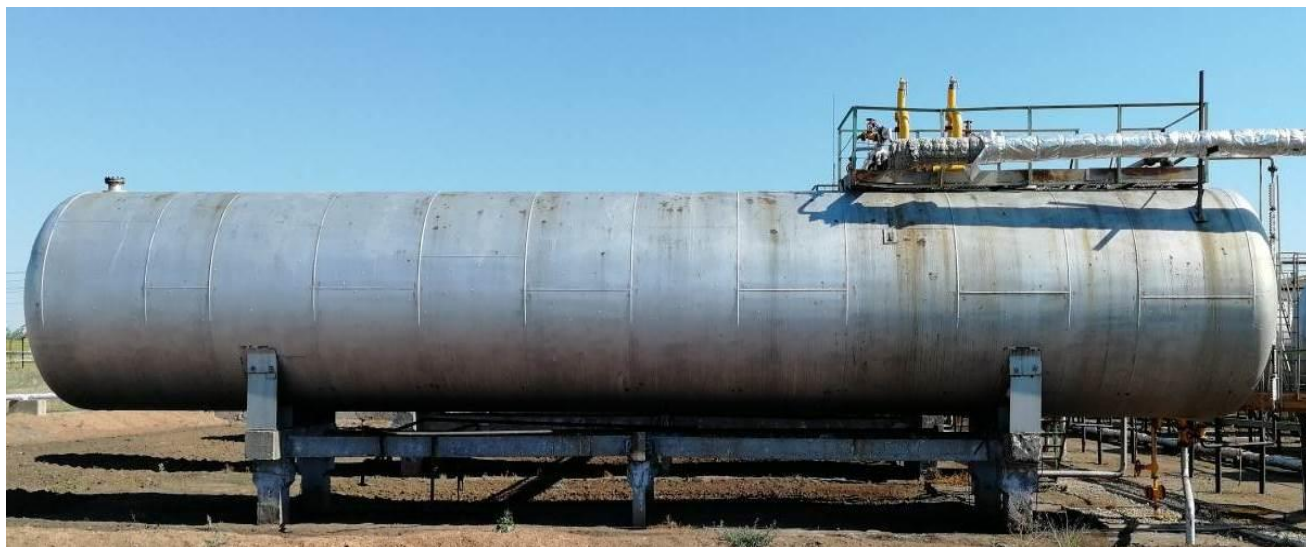
Рисунок 1 - Общий вид резервуара стального горизонтального цилиндрического РГС-200
