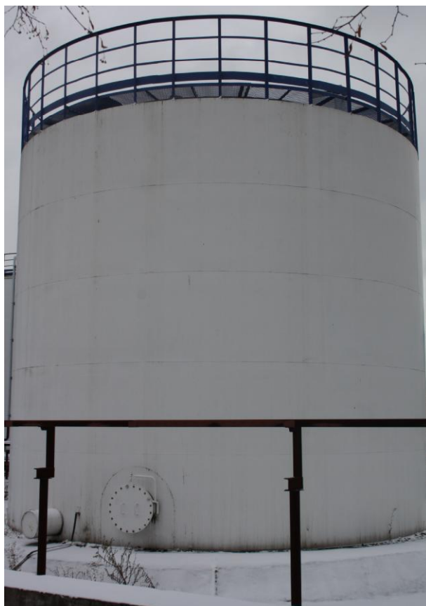
Рисунок 1 - Общий вид резервуара стального вертикального цилиндрического РВС-400
