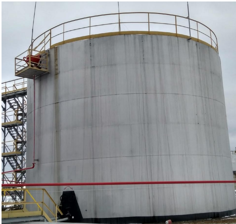
Рисунок 3 - Общий вид резервуара стального вертикального цилиндрического РВС-1000
