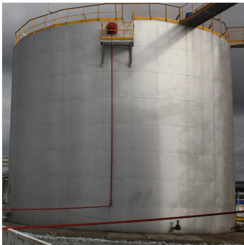
Рисунок 4 - Общий вид резервуара стального вертикального цилиндрического РВС-2000
