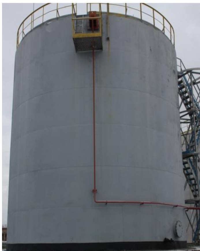
Рисунок 2 - Общий вид резервуара стального вертикального цилиндрического РВС-700
