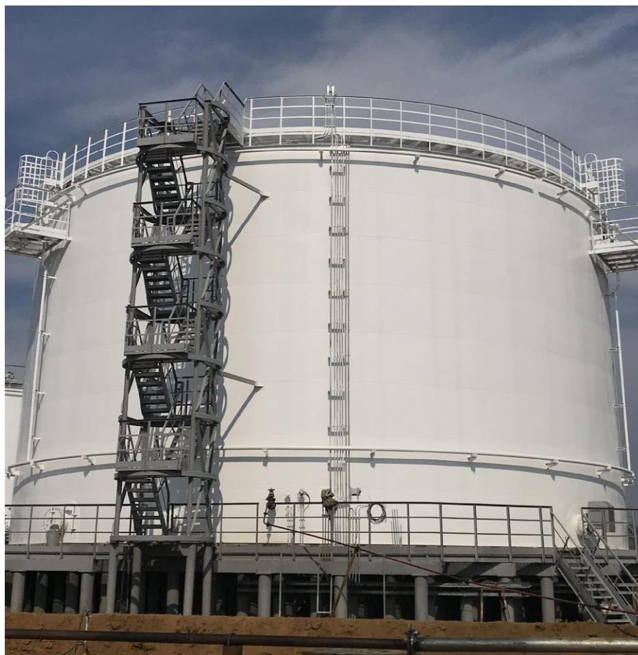
Рисунок 1 - Общий вид резервуара РВС-5000
