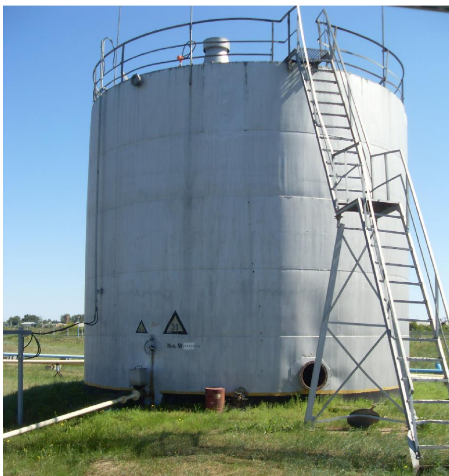
Рисунок 1 - Общий вид резервуара вертикального стального цилиндрического РВС-400
