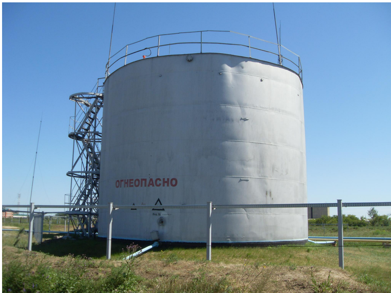
Рисунок 2 - Общий вид резервуара вертикального стального цилиндрического РВС-700
