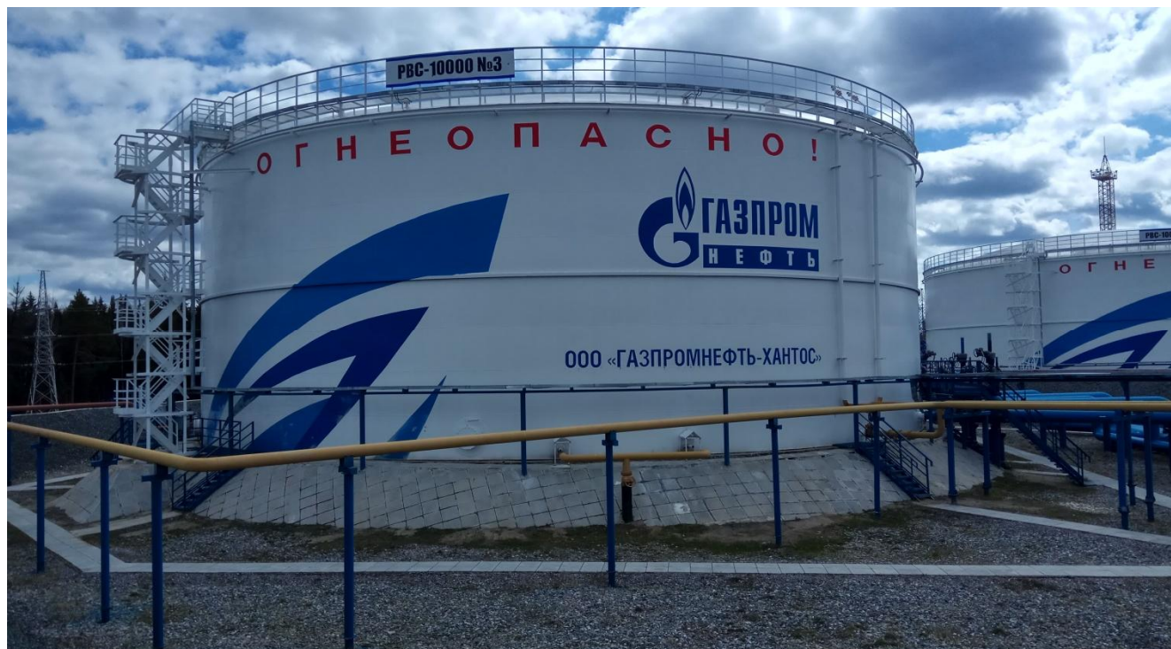
Рисунок 1 - Общий вид резервуара РВС-10000
