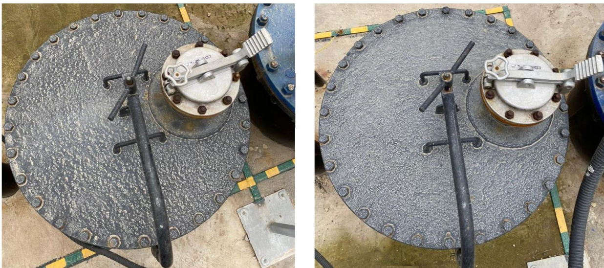
Рисунок 2 – Измерительные люки резервуаров РГС-5
