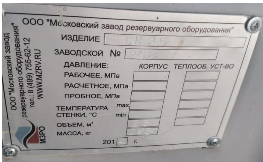
Рисунок 12 – Маркировочная табличка резервуара РГС-25, зав.№208
