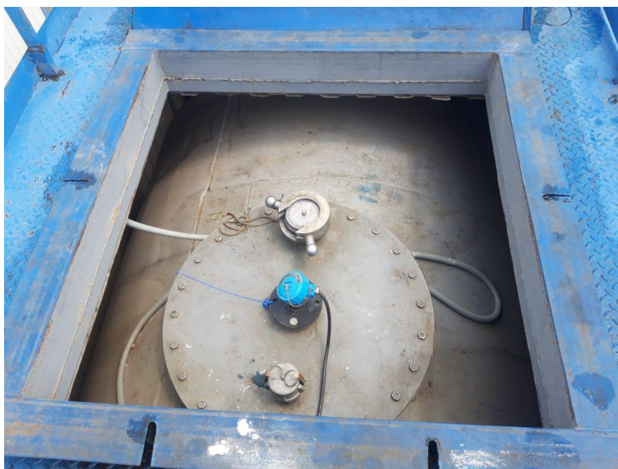
Рисунок 8 – Общий вид резервуаров РГС-25 зав.№№ 205, 206, 207, 208, 209
