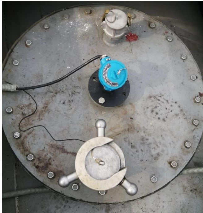
Рисунок 2 – Общий вид резервуаров РГС-25 зав.№№ 221, 222, 223, 224
