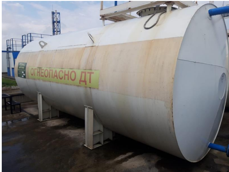
Рисунок 1 – Общий вид резервуаров РГС-25 зав.№№ 221, 222, 223, 224
