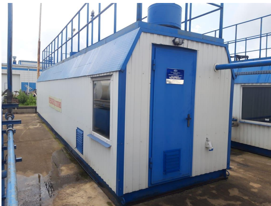
Рисунок 7 – Общий вид резервуаров РГС-25 зав.№№ 205, 206, 207, 208, 209
