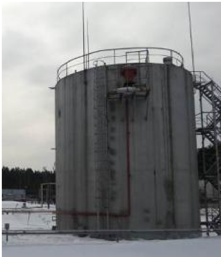
Рисунок 1 – Общий вид резервуара вертикального стального цилиндрического РВС-1000
