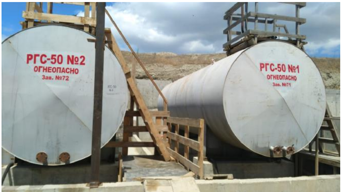
Рисунок 1 - Общий вид резервуаров
