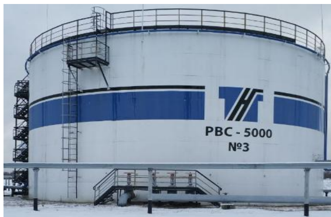
Рисунок 1 - Общий вид резервуара
