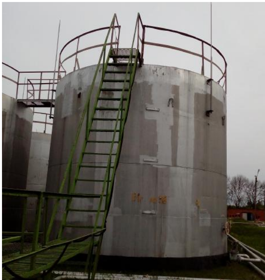
Рисунок 1 - Общий вид резервуара стального вертикального цилиндрического РВС-200
